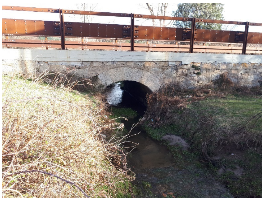
Figura 2 - Ponte della S.S. 389 sul Riu Accu
