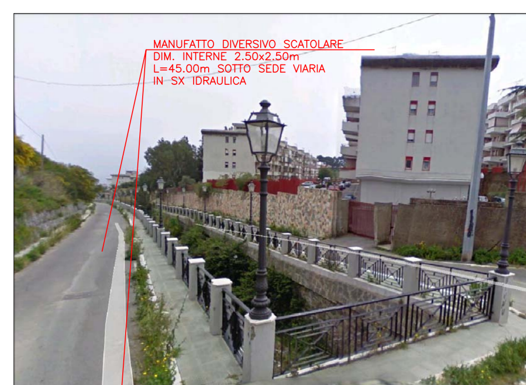
TORRENTE CIARAMITA MANUFATTO M14_A VISTA DA MONTE
