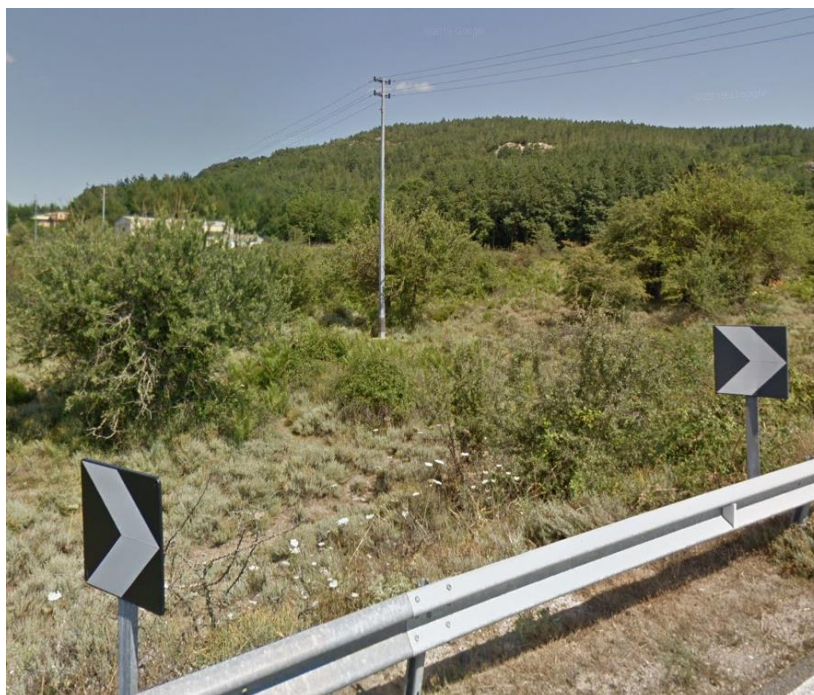
Foto 2 – Interferenza MT001 - Rete elettrica aerea M.T.
