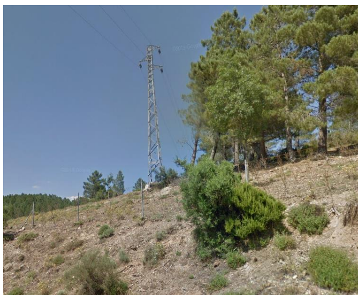
Foto 5 – Interferenza AT001 - Rete elettrica aerea A.T.
