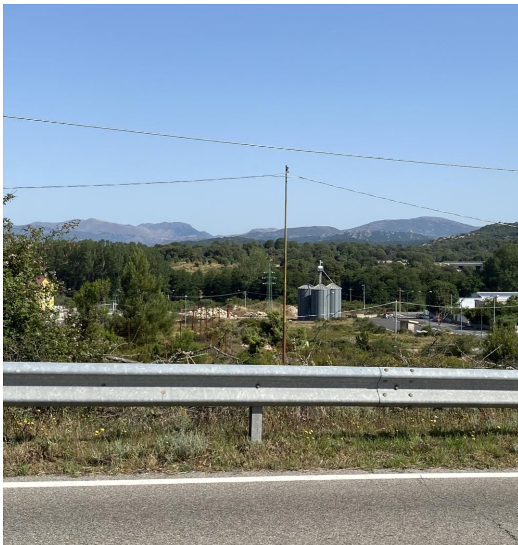
Foto 1 – Interferenza BT001 - Rete elettrica aerea B.T.
