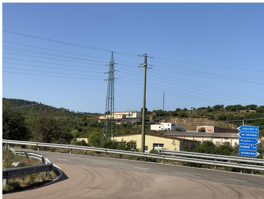
Foto 3 – Interferenza MT002 - Rete elettrica aerea M.T.
