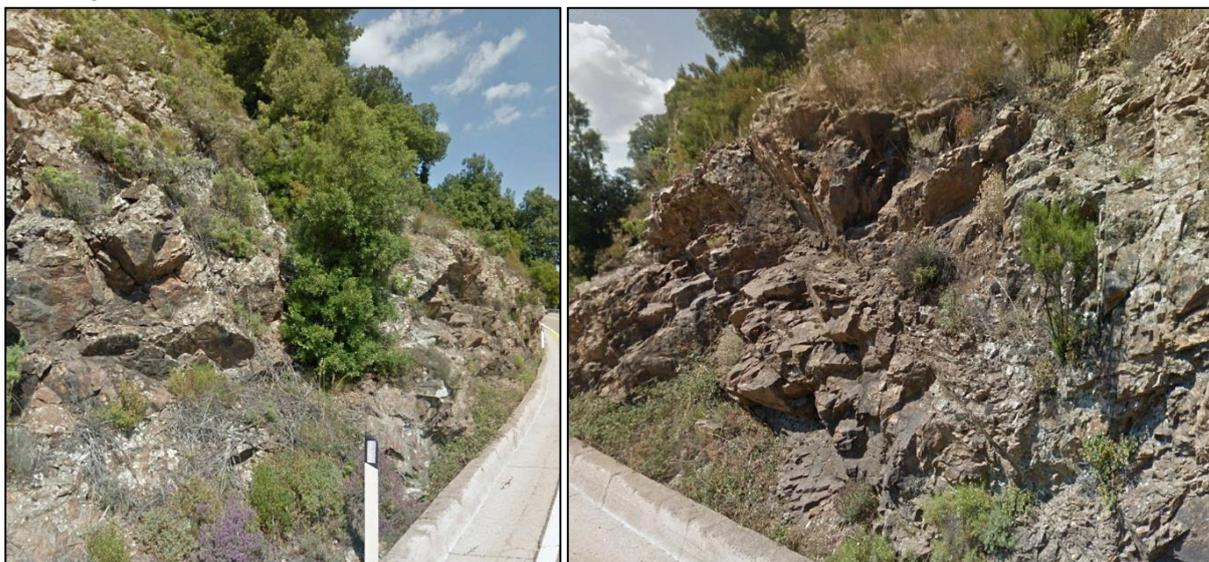
**FIGURA 3.10** – Due esempi di scarpate stradali della S.S. 389 impostate sulle rocce metarenacee e metasitose della Formazione delle Arenarie di San Vito con evidenti situazioni di potenziale instabilità gravitativa (crollo e scivolamento) per effetto della locale giacitura a franapoggio e per la fitta fratturazione (immagini estratte da Street View).
