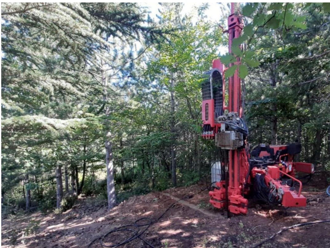
Posizionamento sondaggio SA1
