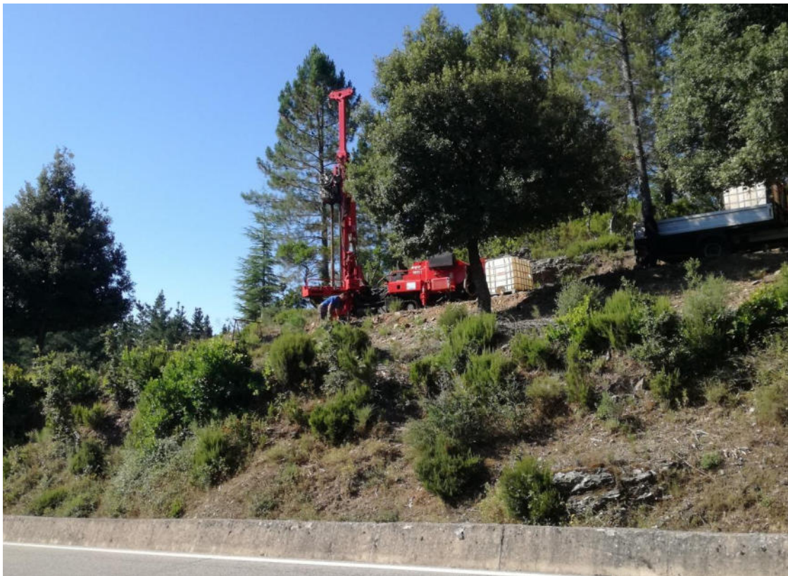
Posizionamento sondaggio SA2
