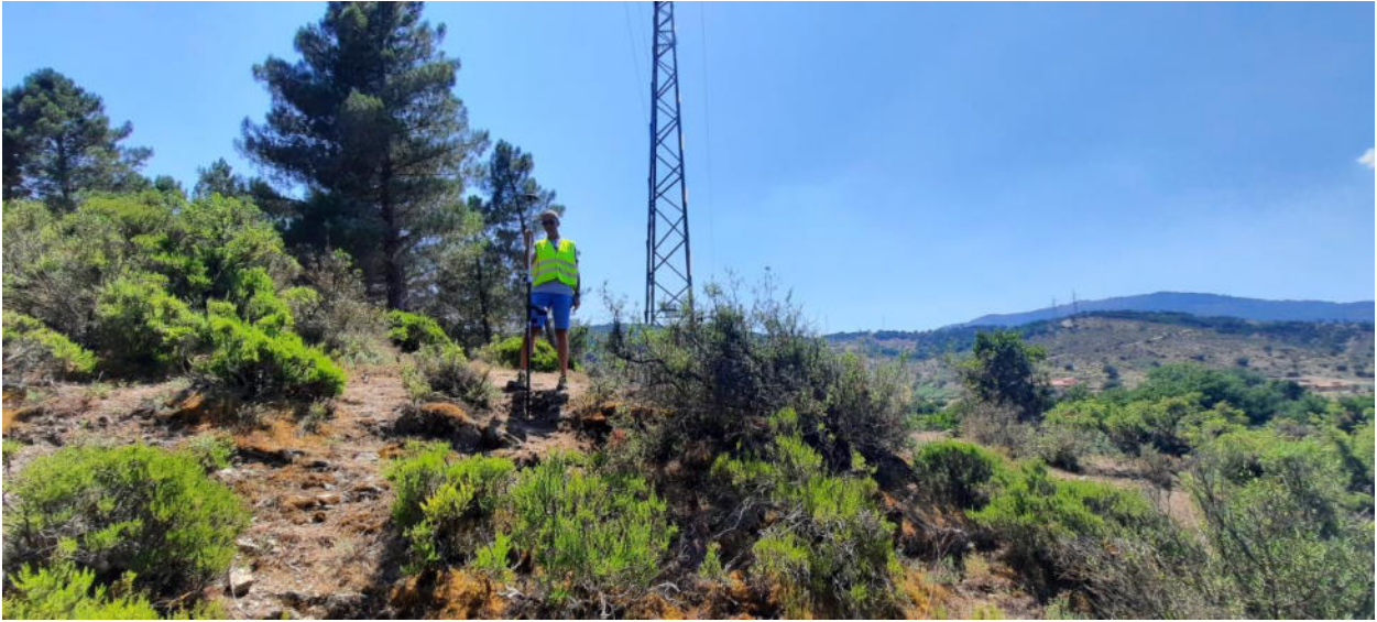
FIGURA 7: Esecuzione del rilievo topografico.
