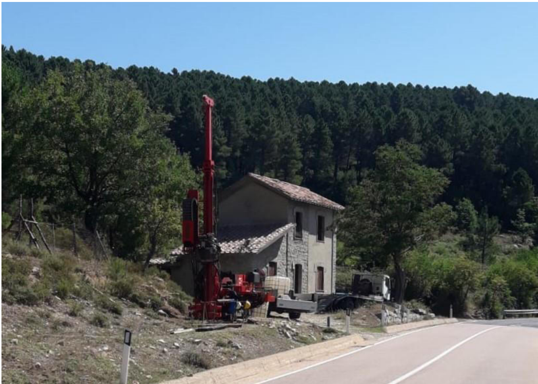
Posizionamento sondaggio SA3
