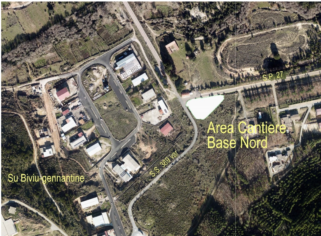
Figura 2- Vista aerea dell'area di cantiere Nord
