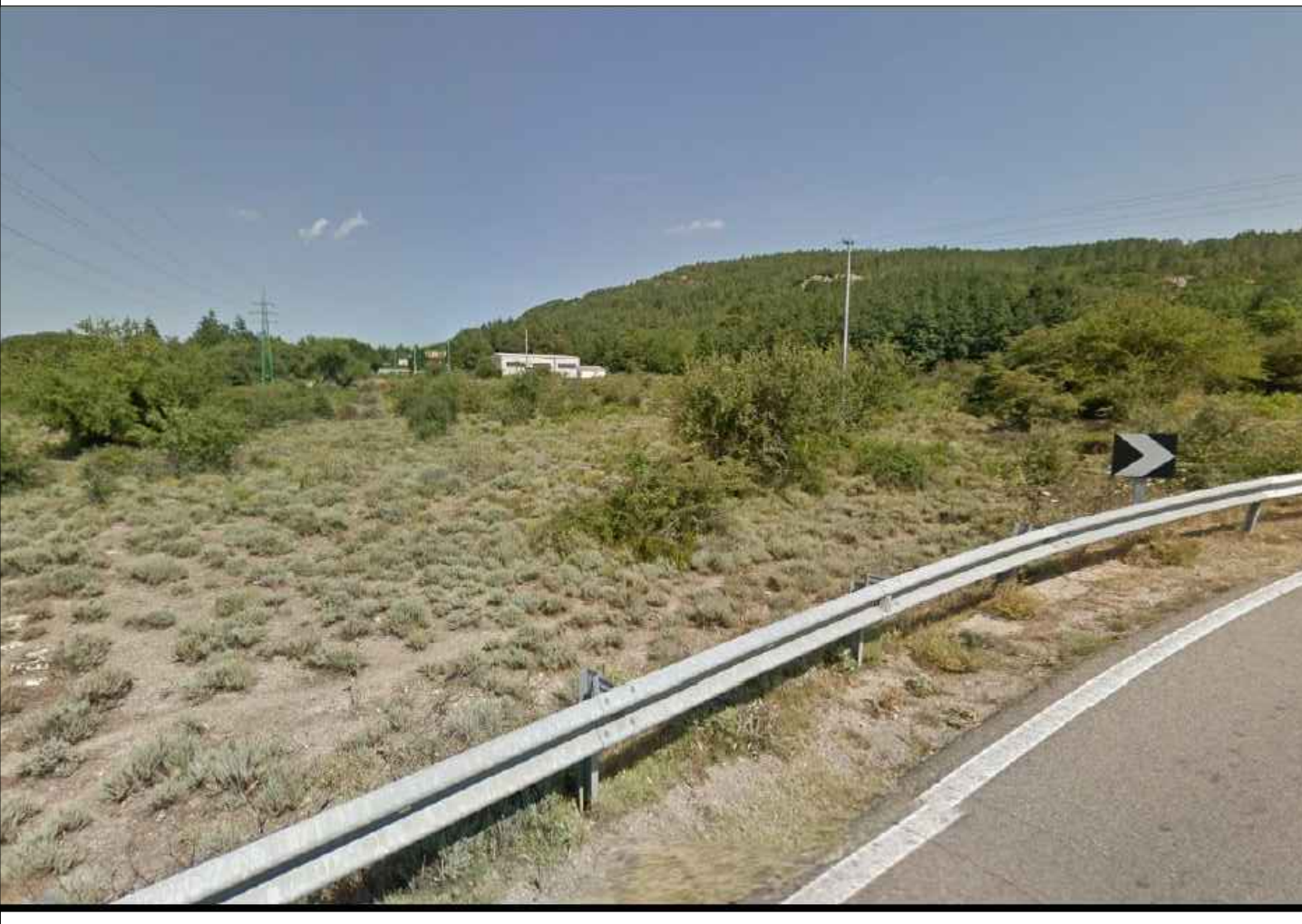
foto 1 - Rotatoria Nord verso Galleria GA01 - visuale parzialmente interclusa dalla vegetazione
