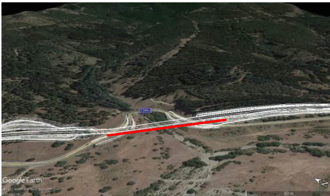
Figura 6-11 – vista del tracciato, viadotto VI04 attraversamento riu Idolo
