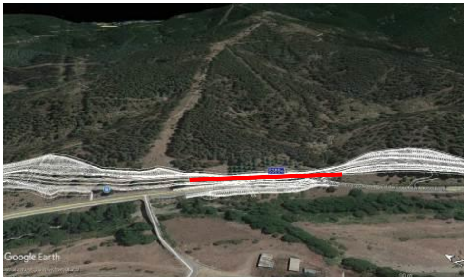
Figura 6-10 – vista del tracciato, viadotto VI03
