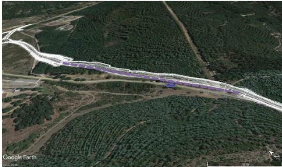
Figura 6-4 vista del tracciato, galleria GA01
