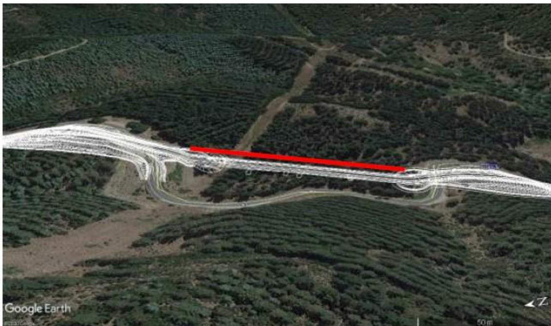
Figura 6-6 Vista del tracciato, viadotto VI01
