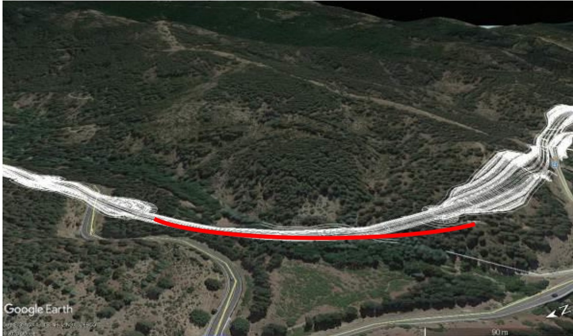
Figura 6-8 – vista del tracciato, viadotto VI02
