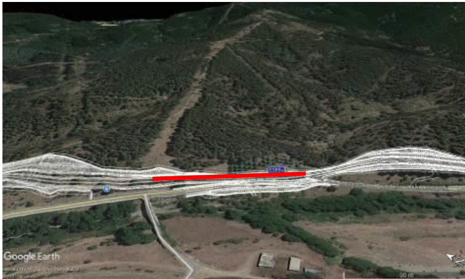
Figura 81 – vista del tracciato, viadotto VI03
