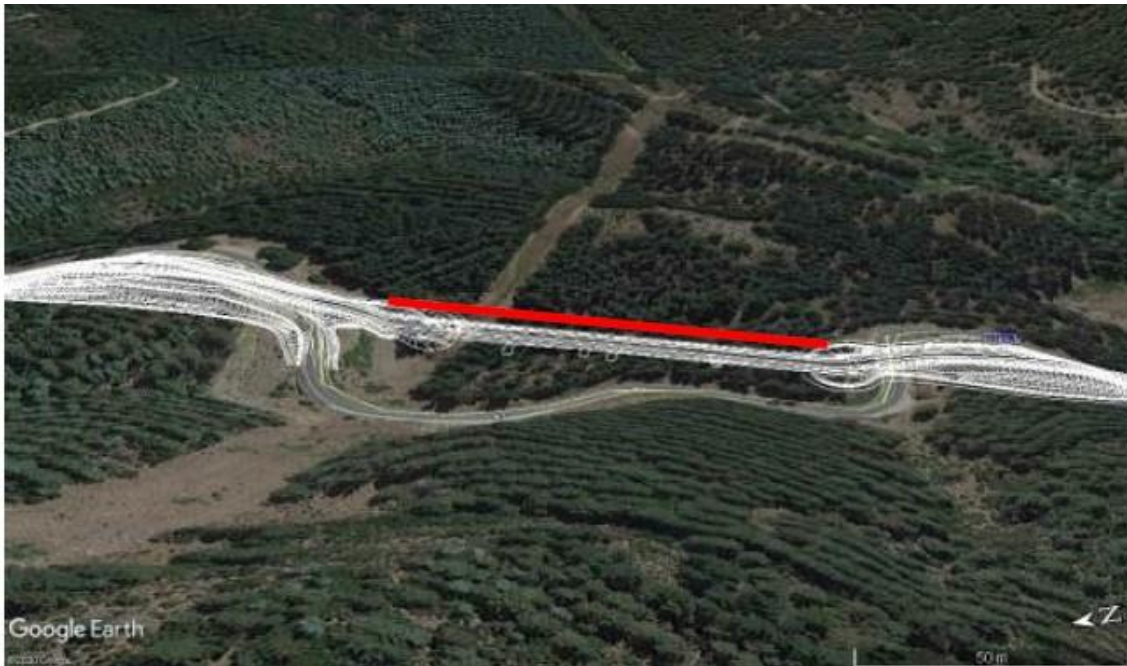
Figura 78 Vista del tracciato, viadotto VI01
