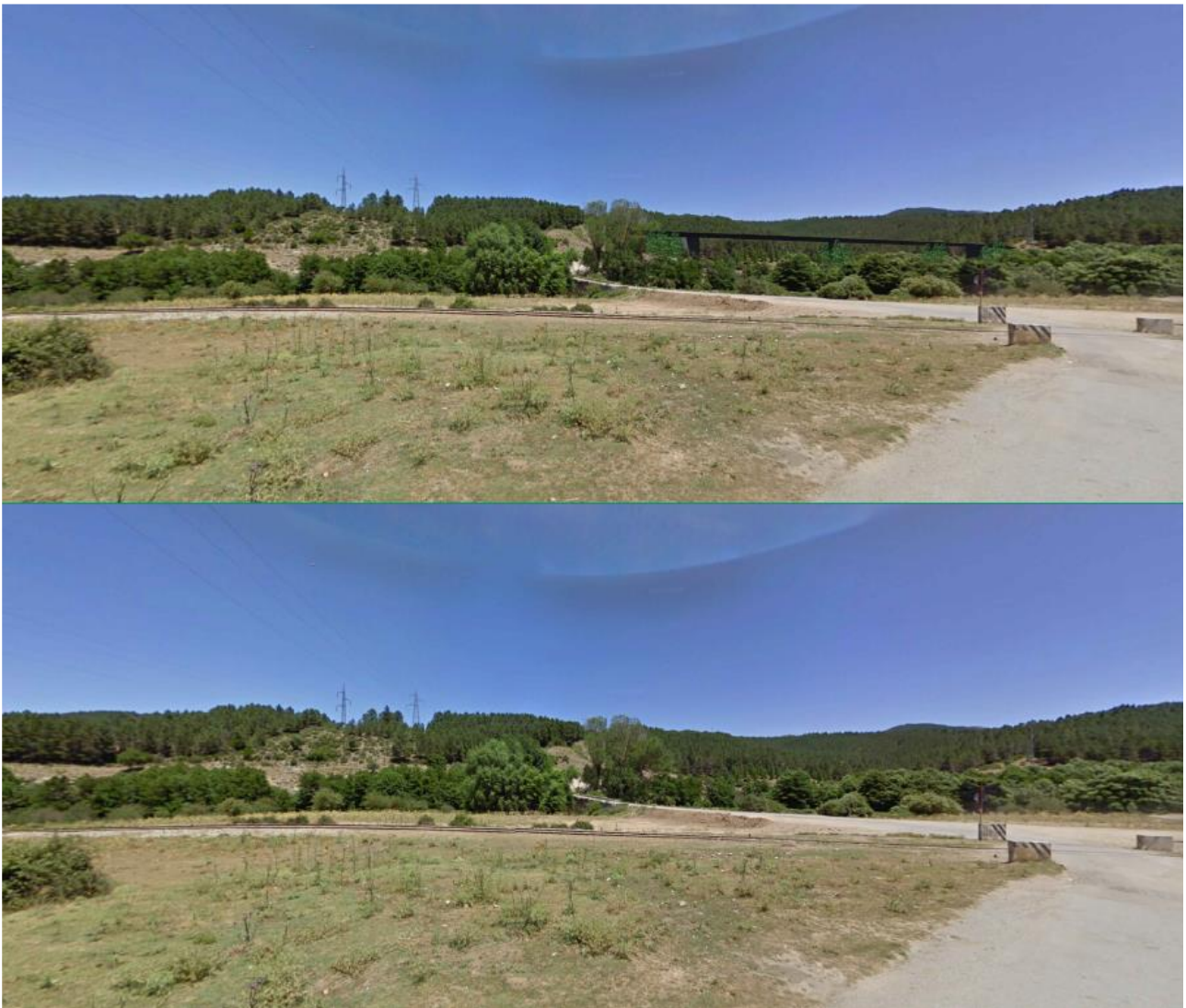
Figura 27- Vista del Viadotto VI03 dal fondovalle, ante e post opera
