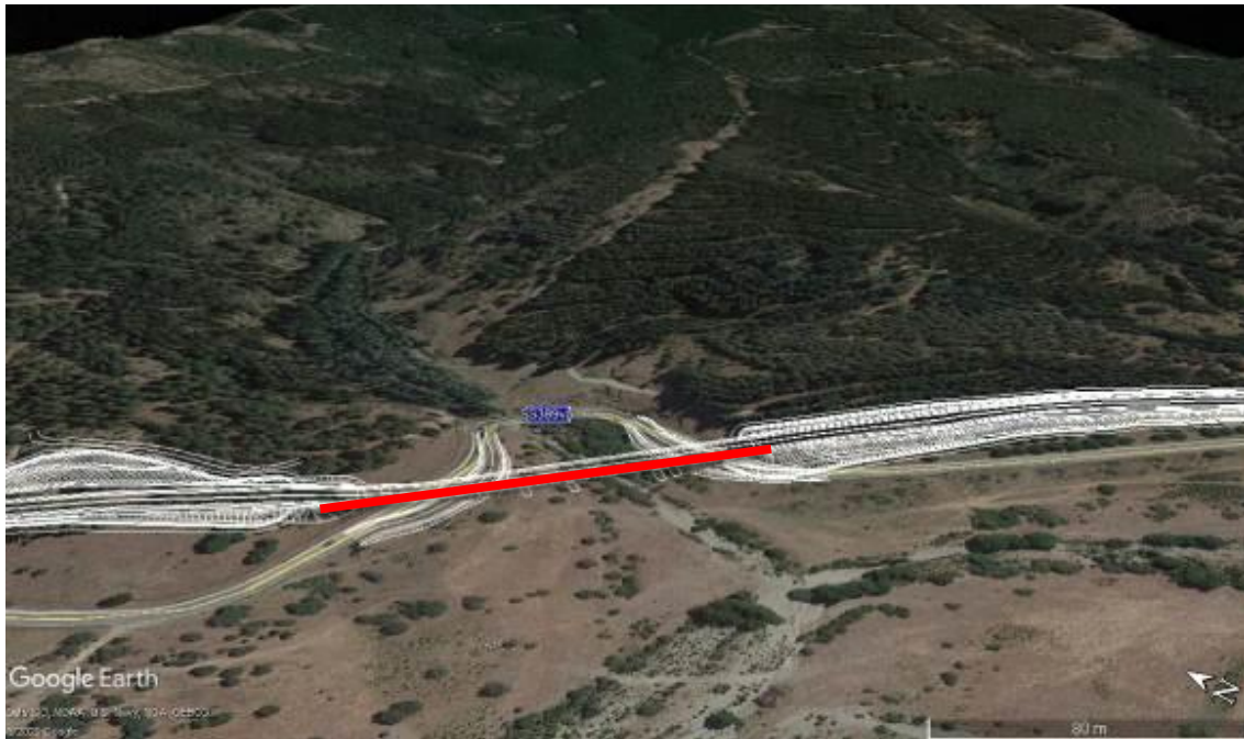
Figura 82 – vista del tracciato, viadotto VI04 attraversamento riu Idolo
