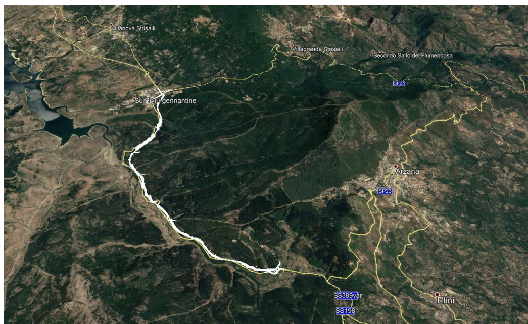
Figura 1 - Area di studio Lotto Bivio Villagrande – Svincolo di Arzana – vista complessiva tracciato di progetto
