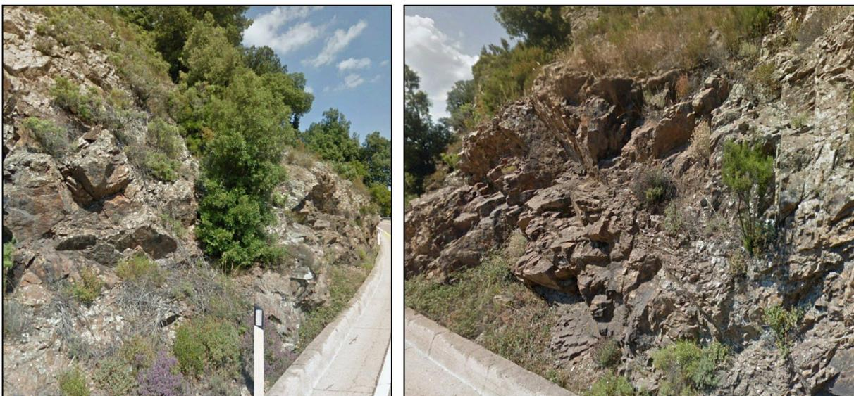
**FIGURA 1.9** – Due esempi di scarpate stradali della S.S. 389 impostate sulle rocce metarenacee e metasitose della Formazione delle Arenarie di San Vito con evidenti situazioni di potenziale instabilità gravitativa (crollo e scivolamento) per effetto della locale giacitura a franapoggio e per la fitta fratturazione (immagini estratte da Street View).
