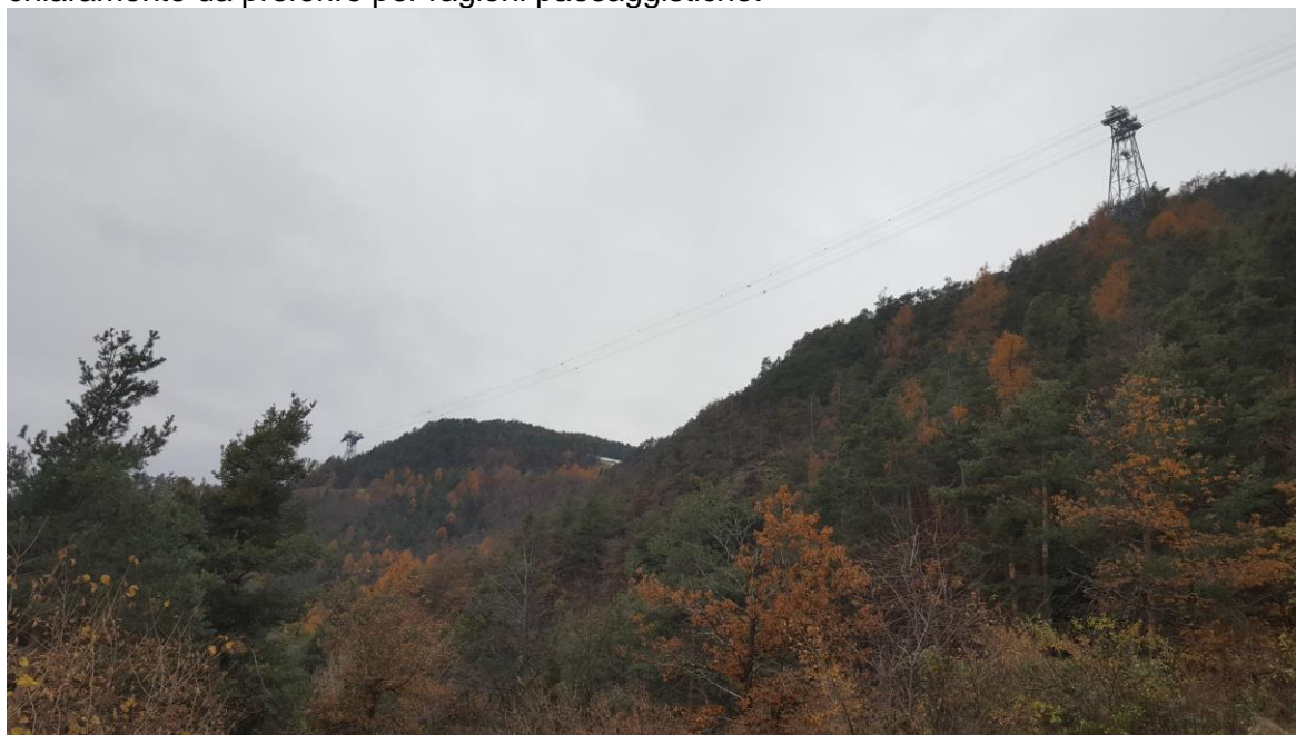
Foto n.5: in questa zona la linea dell'alternativa progetto sottopassa la Funivia Bolzano-Renon
