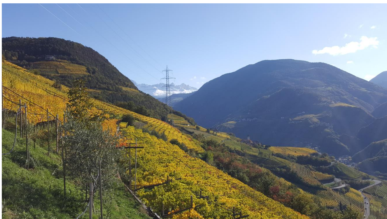
Già qualche anno fa è stata potenziata una linea di alta tensione, che passa il paesaggio rurale dei pendii sopra Bolzano verso il Monte Tondo (Foto nella zona di Sopra Maddalena verso Est in direzione del monte Catinaccio)
