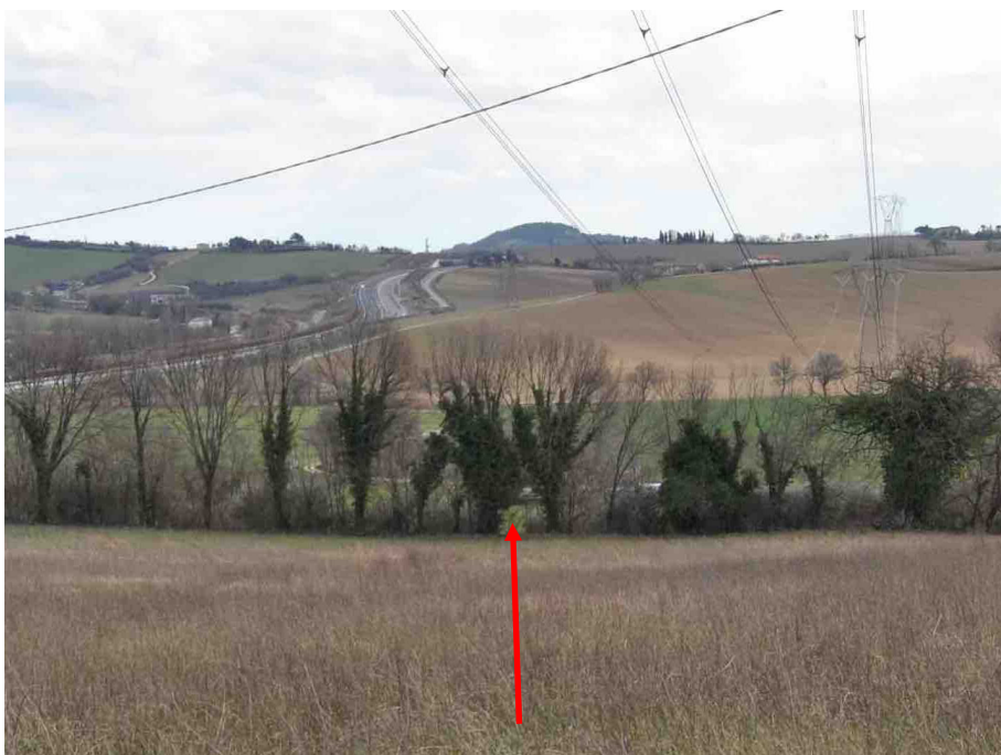
Foto n.21: Filare da abbattere in Comune di Gradara, al km 78+410
