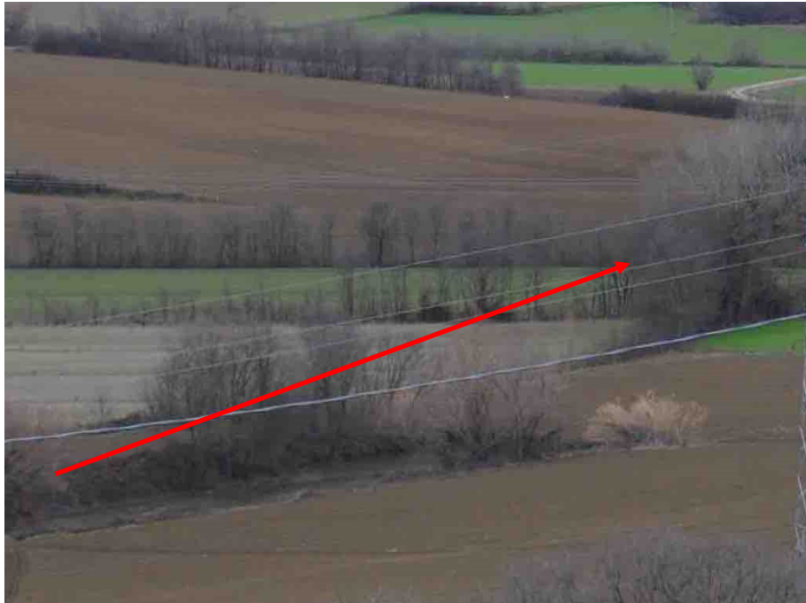
Foto n.34: Filare al km 99+142 della linea in progetto
