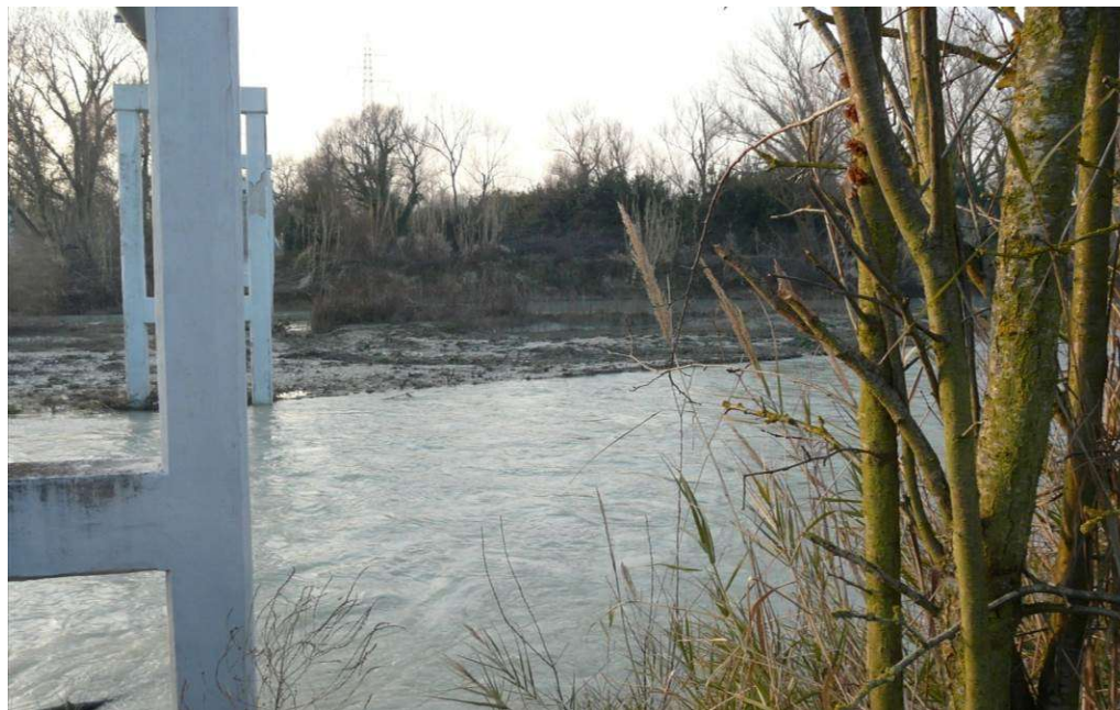
Figura 3.2/M: Particolare dell'attraversamento della condotta sul Fiume Esino (da riva destra)
