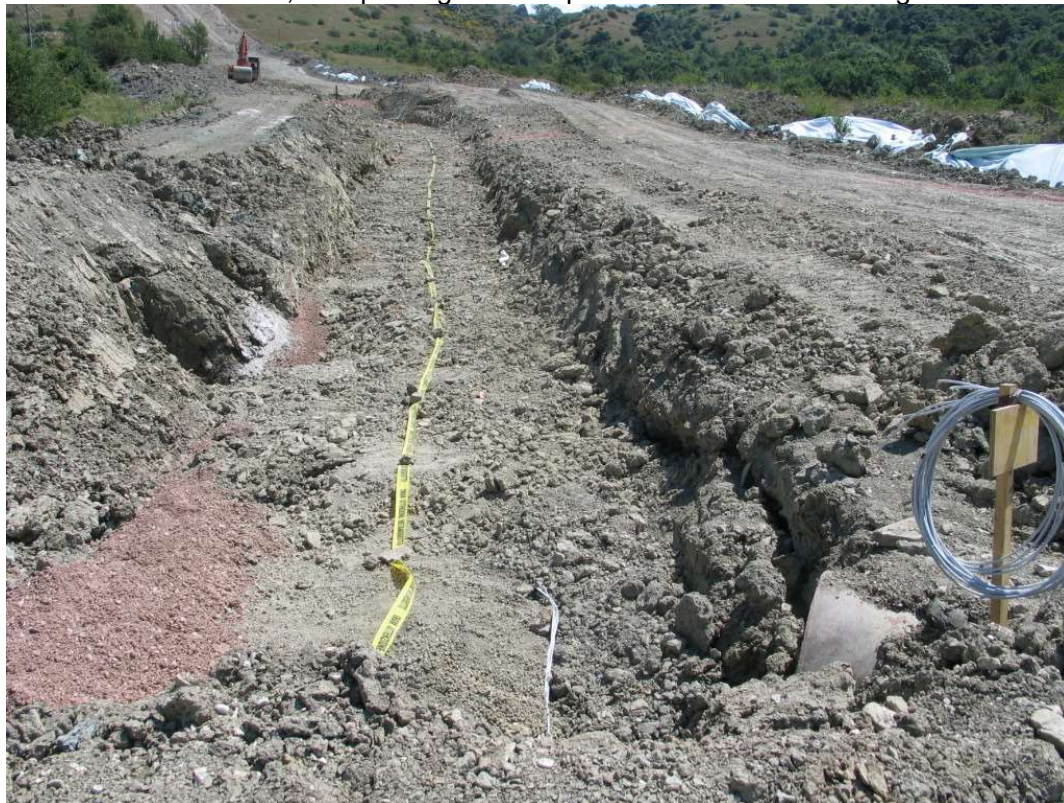
Figura 2.9/A: Rinterro della condotta
