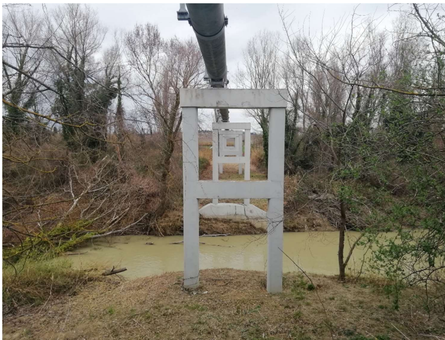
Figura 3.2/F: Corridoio interessato dalla condotta in dismissione
