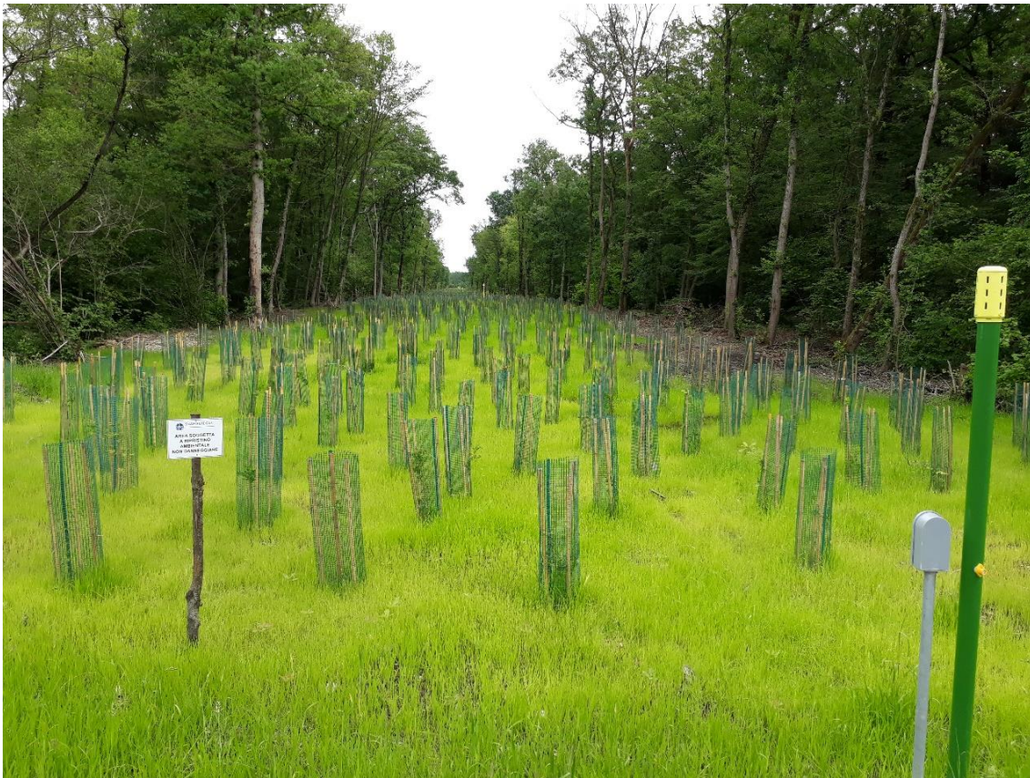
Figura 2.4. Ripristino vegetazionale in area boscata realizzato tramite messa a dimora di giovani piante in protezione singola e idrosemina del cotico erboso
