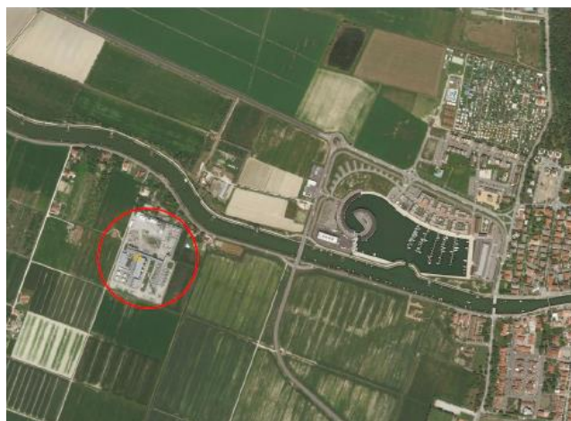
Figura 3.1-8: Esempi di centrale di raccolta di gas naturale di media dimensione in pianura Padana (area ravennate)
