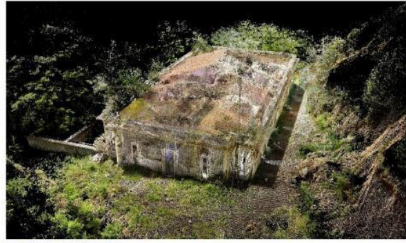
EDIFICIO CASA FILTRI
