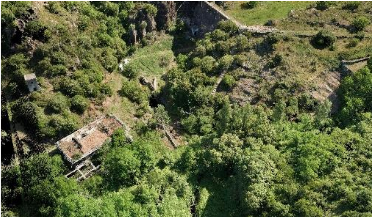
Figura 24 : Rilievo Lidar da drone dell'area a valle della diga Bunnari Basso
