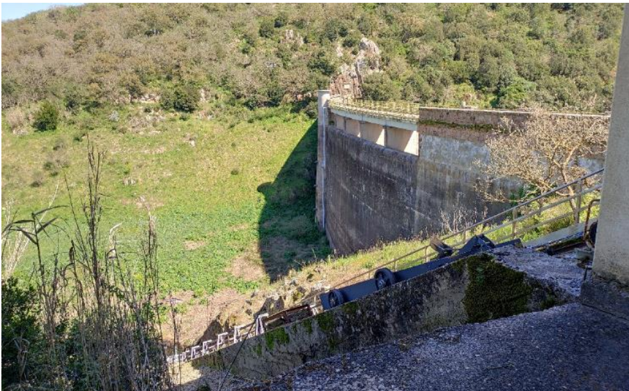
Figura 19 : Diga di Bunnari Alta – Vista da monte della diga con paratoia piana (in primo piano) e torrino di presa
