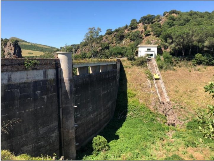
Figura 2 : Ripresa della torretta di presa di Bunnari Alto, da cui sono visibili n°3 delle complessive n°4 bocche di derivazione dell'acqua
