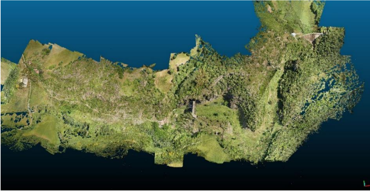
Figura 25 : Rilievo Lidar da drone dell'area completa - Diga Bunnari Alto e Basso compreso il sentiero di accesso alle aree
