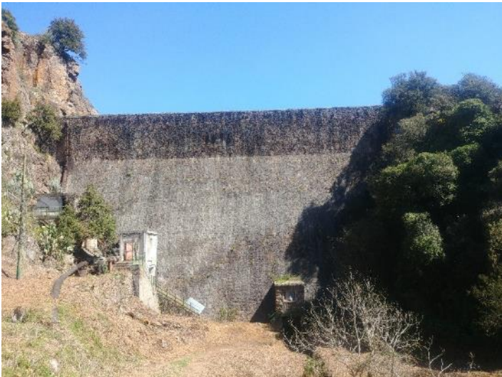
Figura 13: Vista del paramento di valle e dello scarico di fondo della diga Bunnari Basso
