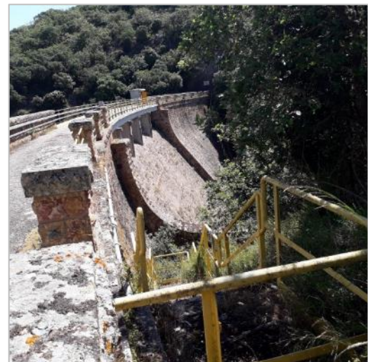
Figura 14: Vista del paramento di valle e degli organi di sfioro della diga Bunnari Alto
