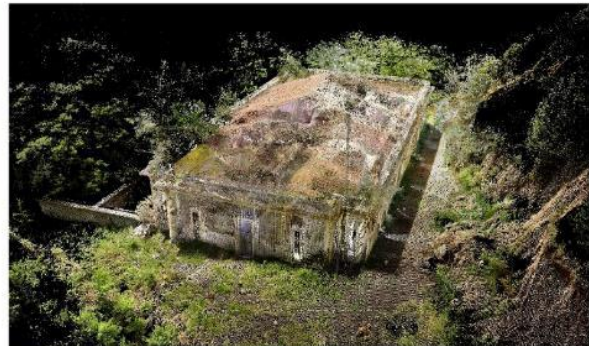
EDIFICIO CASA FILTRI
