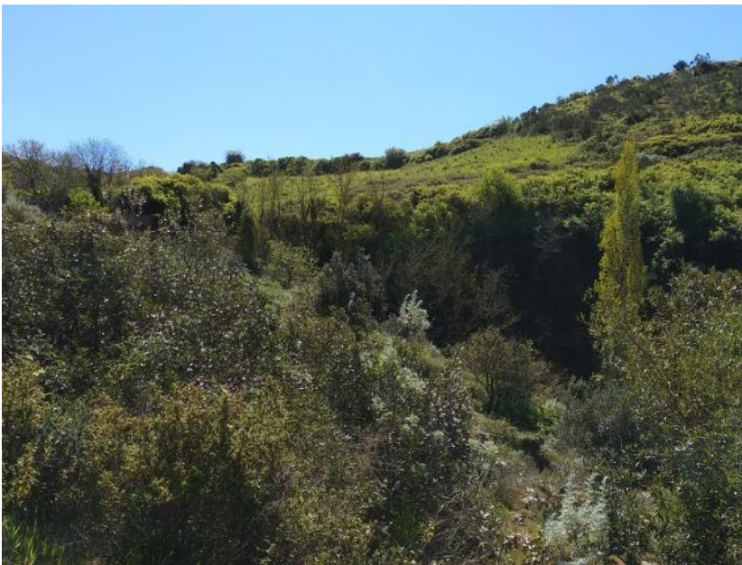
Figura 21 : Vista panoramica - Area soggetta a soliflusso superficiale in sponda sx a valle del canale fuggatore
