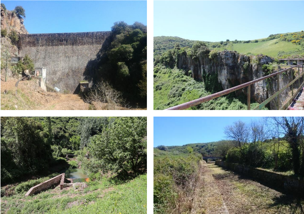
Figura 2: Foto dei luoghi dell'intervento: Paramento diga, fronte roccioso a monte della diga, manufatti idraulici.
