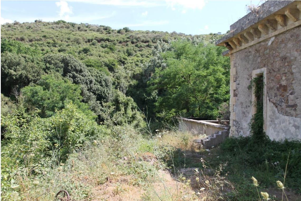
Veduta Est dell'area dell'Edificio Filtri
