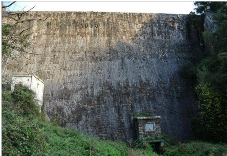
Figura 2: Vista del paramento di valle e dello scarico di fondo della diga Bunnari Basso
