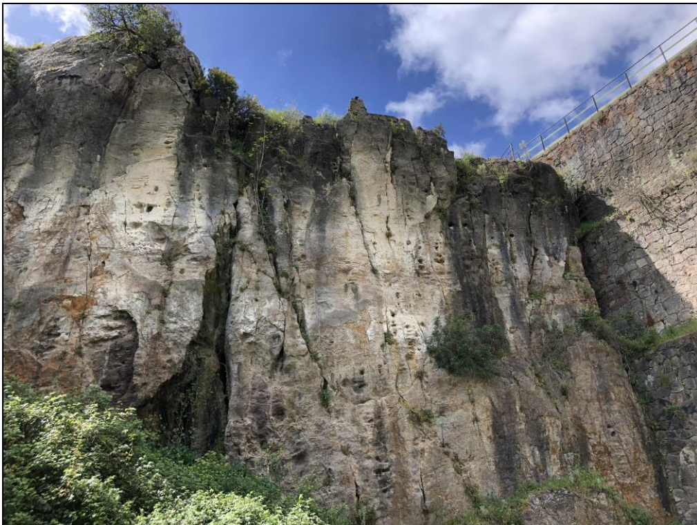
FOTO 4: Pareti rocciose a monte diga
