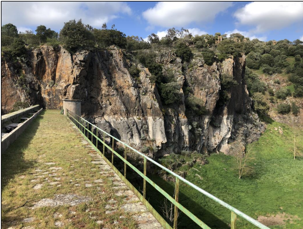
FOTO 23: Pareti rocciose su spalla destra della diga
