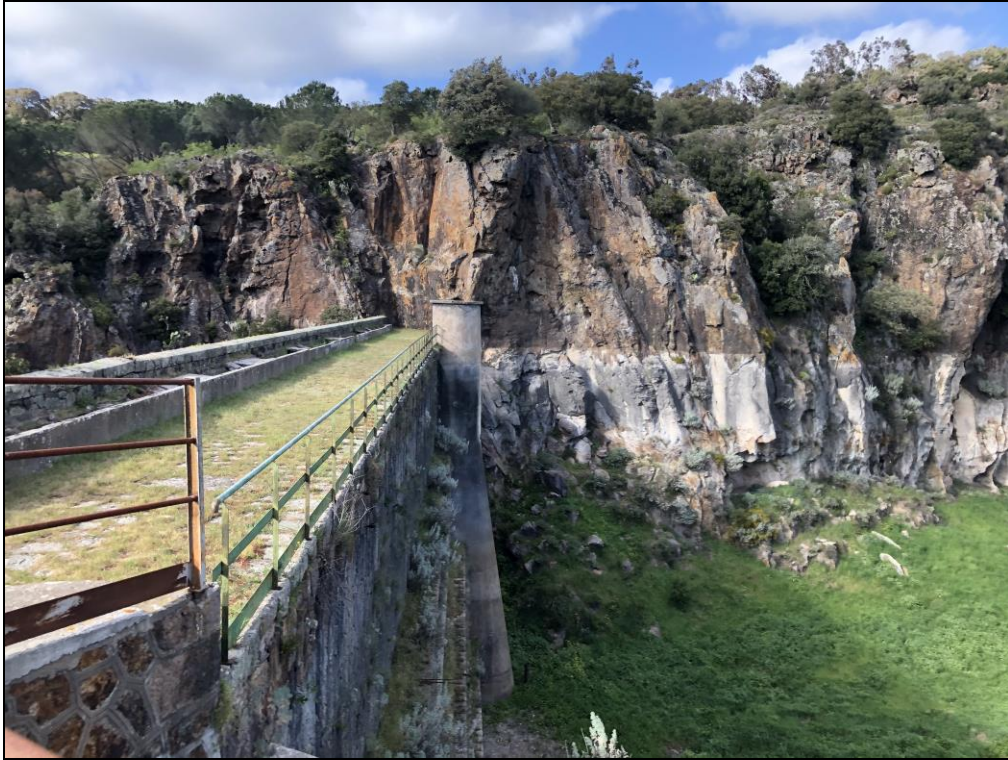
FOTO 24: Pareti rocciose su spalla destra della diga
