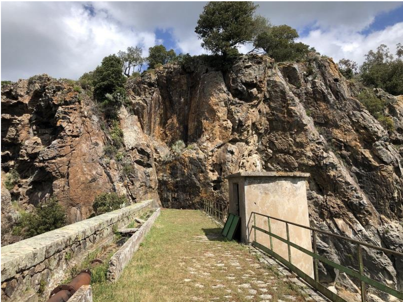
Foto 3: Vista panoramica pareti fortemente fratturate sponda imposta diga.
