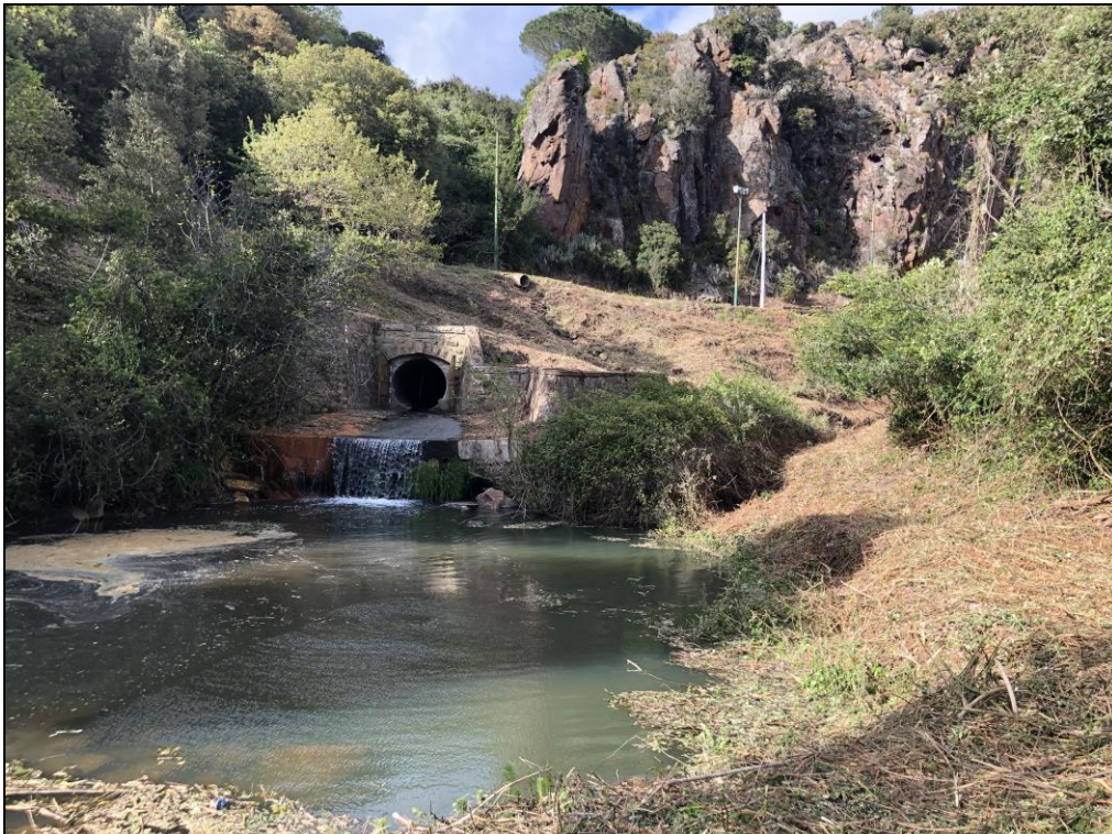
FOTO 18: Panoramica zona dello scaricatore
