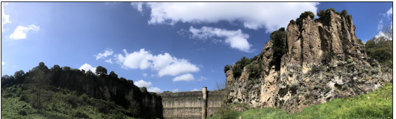
FOTO 10: Panoramica ammasso roccioso in corrispondenza della diga
