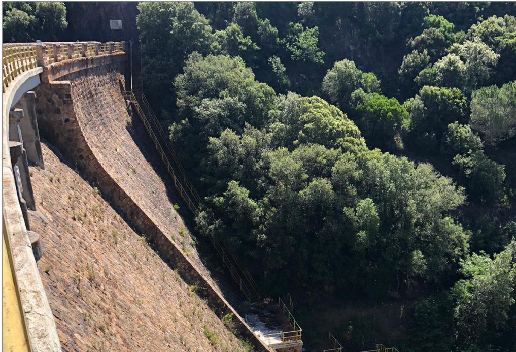
Figura 4-5 – Vista del paramento di valle della diga di Bunnari Alto
