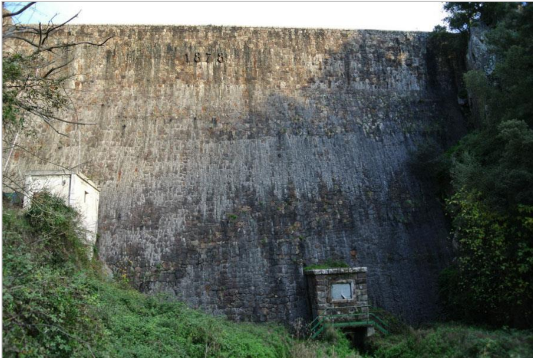
Figura 1-1 – Vista del paramento di valle e dello scarico di fondo della diga Bunnari Basso
