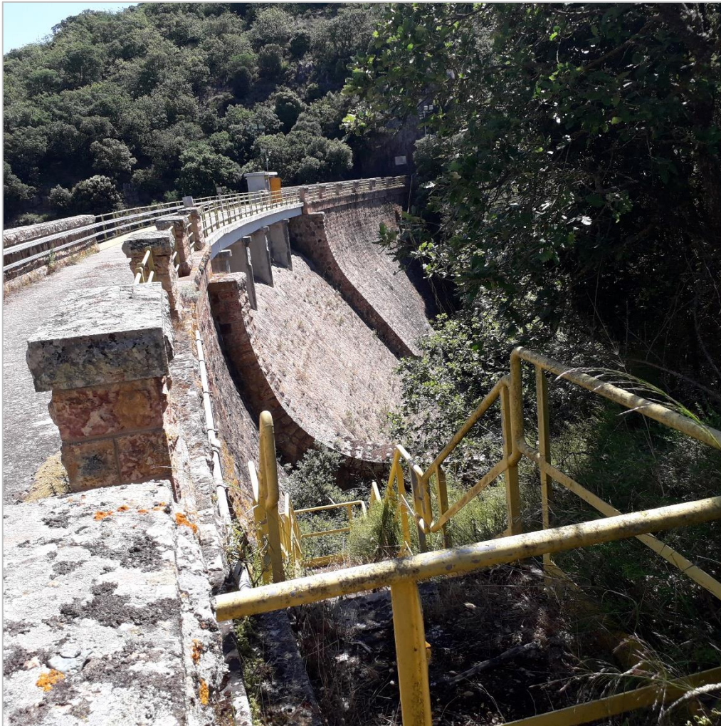
Figura 1-2 – Vista del paramento di valle e degli organi di sfioro della diga Bunnari Alto
