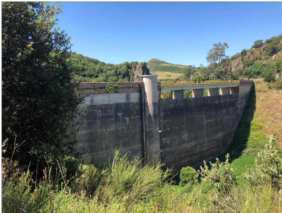
Figura 4-4 – Vista da monte dello sfioratore di superficie della diga di Bunnari Alto
