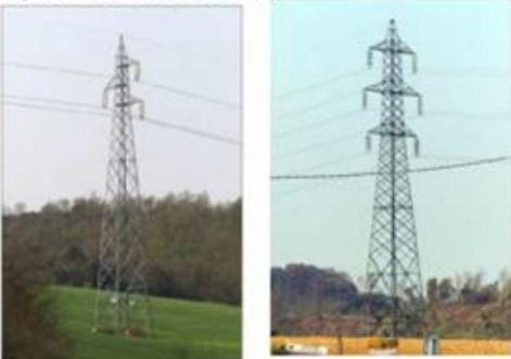
**Sostegni autoportanti a traliccio a profilati angolari
