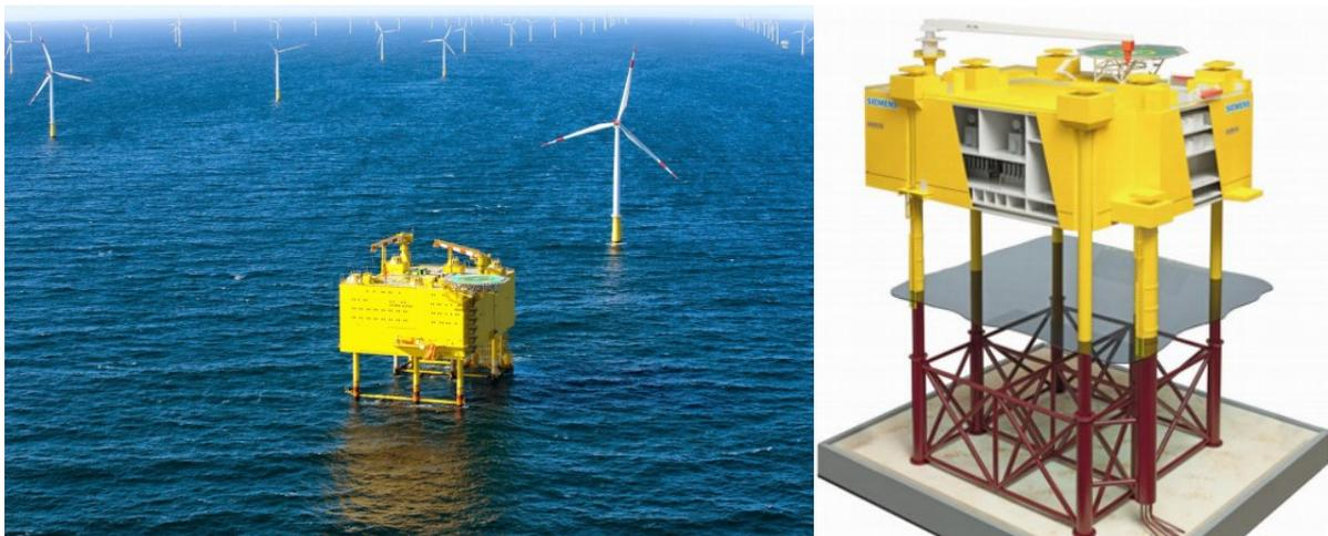
Figura 18 – Stazione HVAC di trasformazione 66/245 kV
