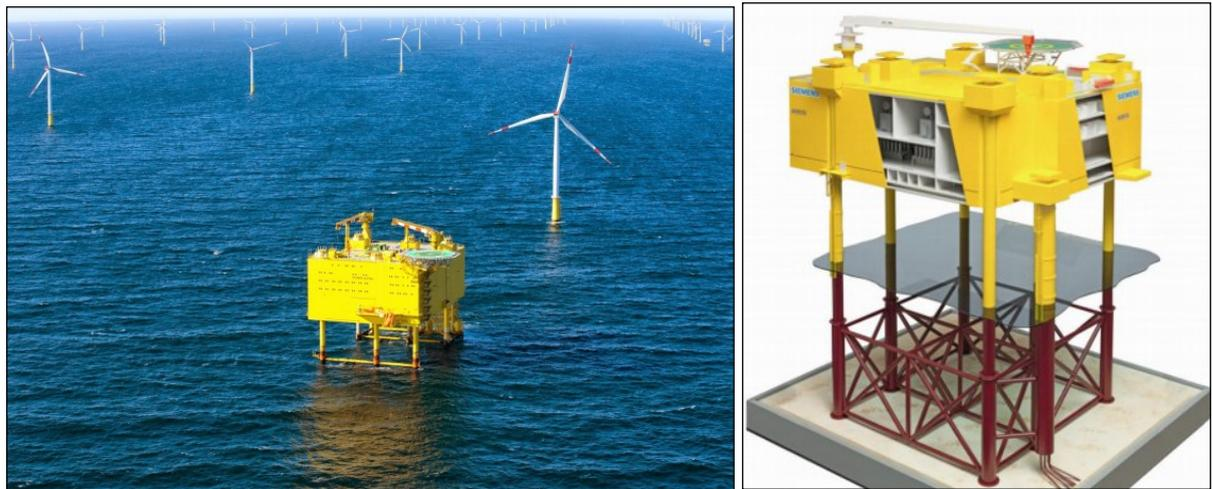
Fig. 10 - Stazione HVAC di trasformazione 66/245 kV
