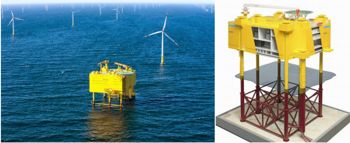
Figura 9 – Stazione HVAC di trasformazione e conversione 66/245 kV
