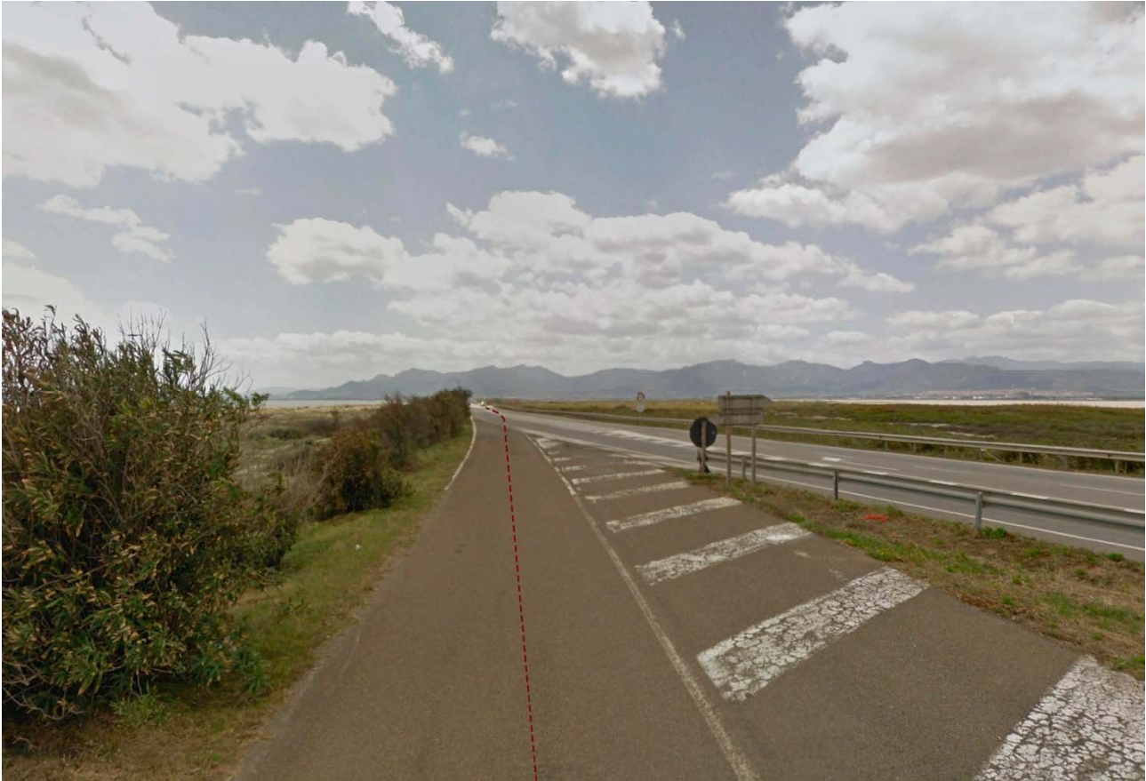
Vista 2_Svincolo ingresso SS195
