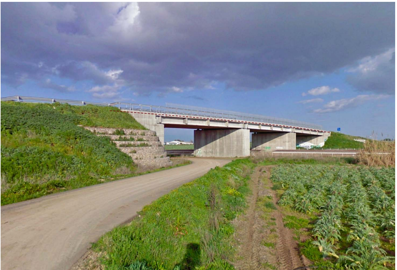
Vista 16_Sovrappasso su linea ferroviaria
