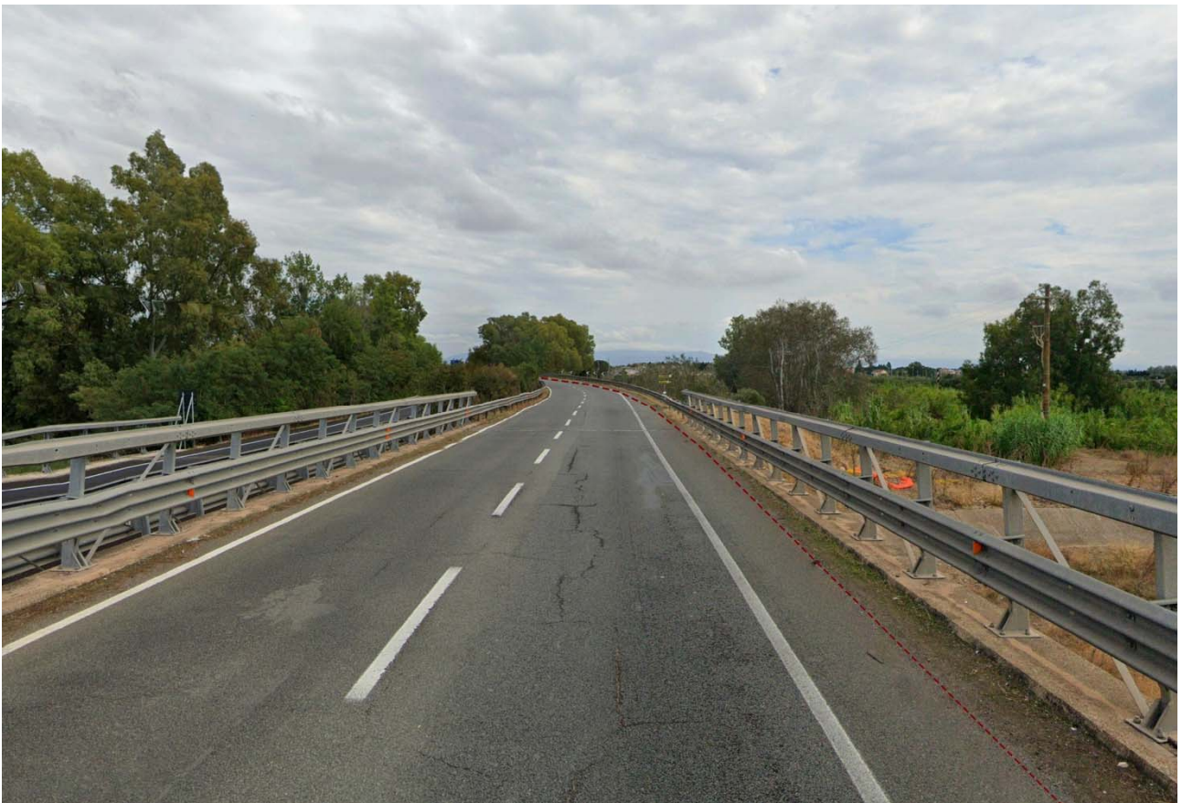
Vista 14_ SS130 viadotto su torrente Leni
