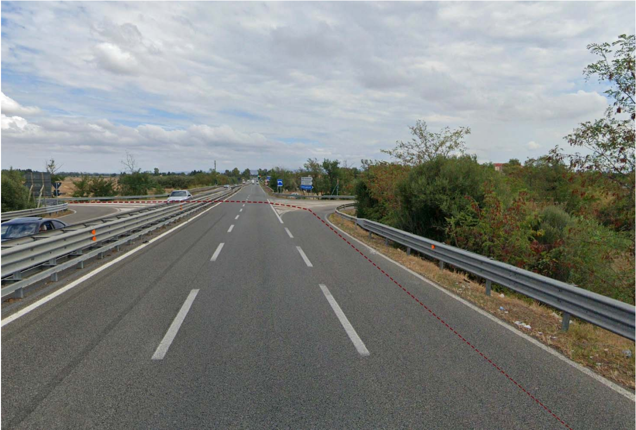
Vista 15_Svincolo tra SS130 e SS196 di Villacidro
