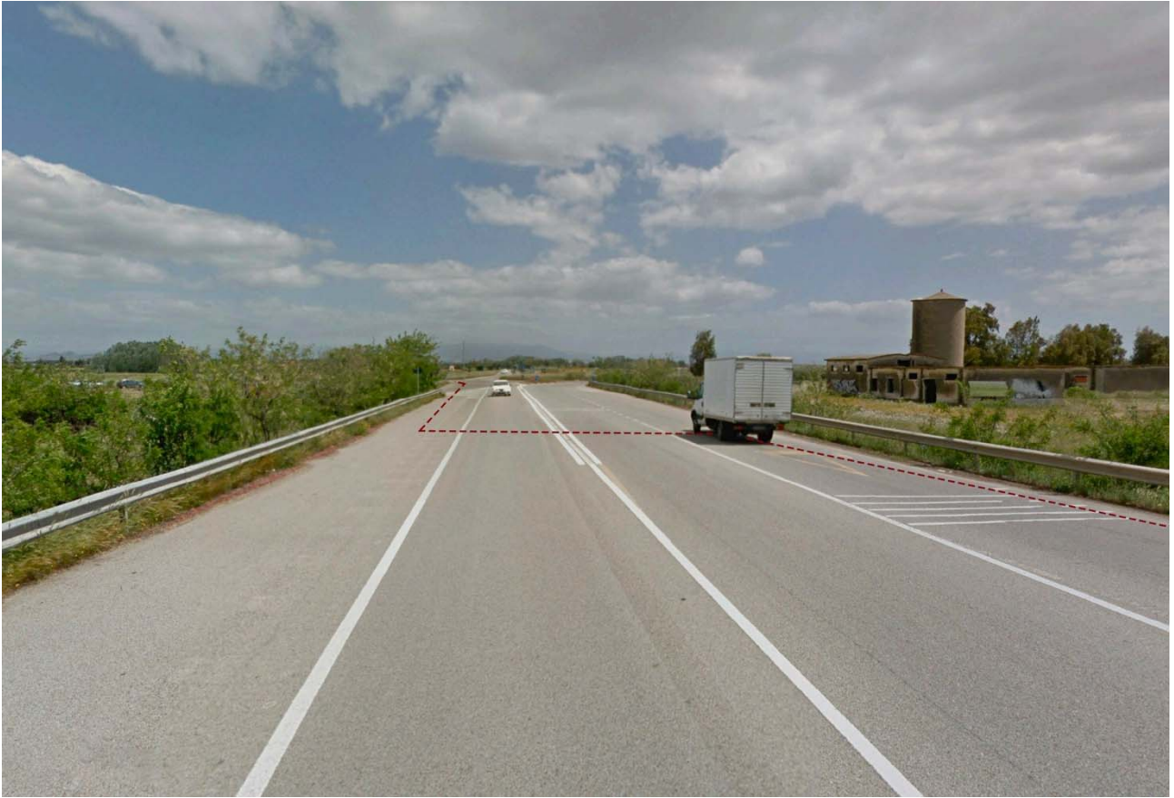
Vista 7_ Svincolo su SP2
