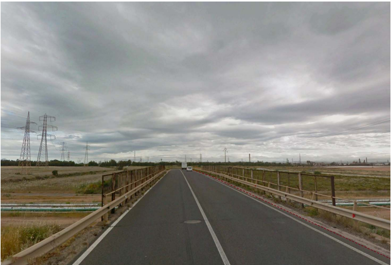
Vista 5_Strada consortile Macchiareddu sovrappasso tubazione oleodotto
