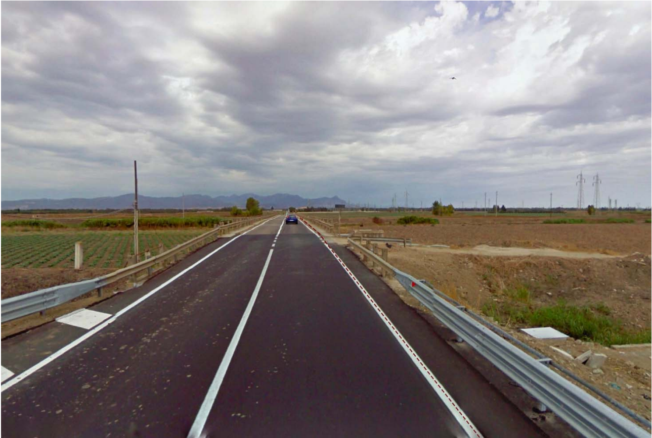
Vista 17_ SS196 viadotto su torrente Leni
