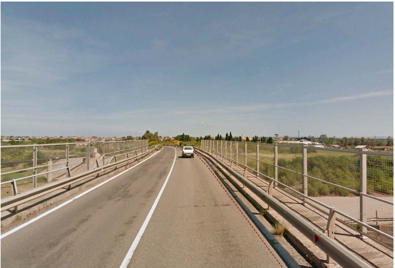
Vista 8_Via Sant' Ambrogio: viadotto
