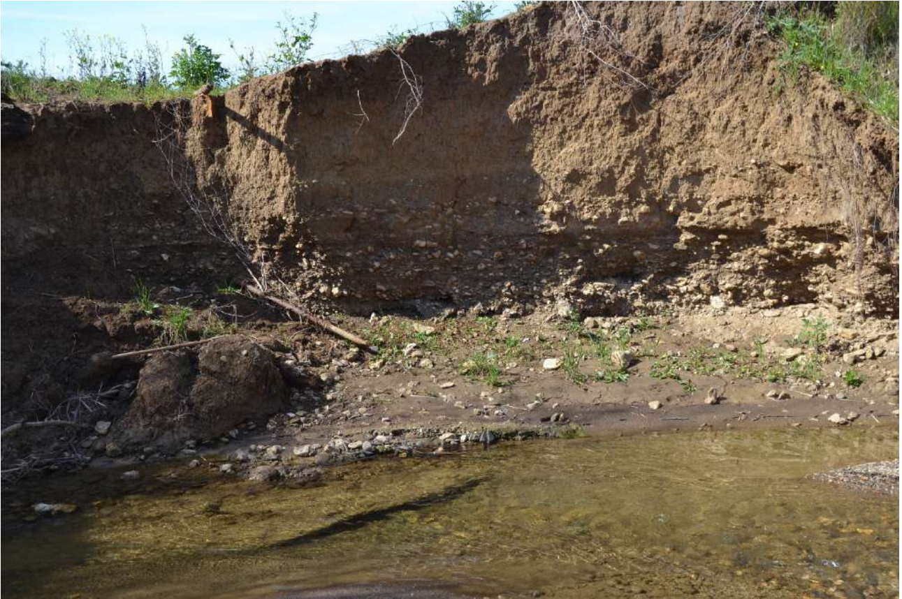
Fig. 19: strada dell'Abbadia, sopralluogo: foto 9: depositi alluvionali nel letto del Tafone
