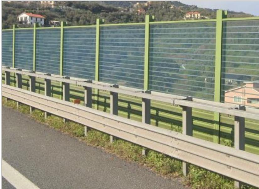
Figura 2.2/4 Pannelli in PMMA con trattamento con sabbiatura-abrasione superficiale
