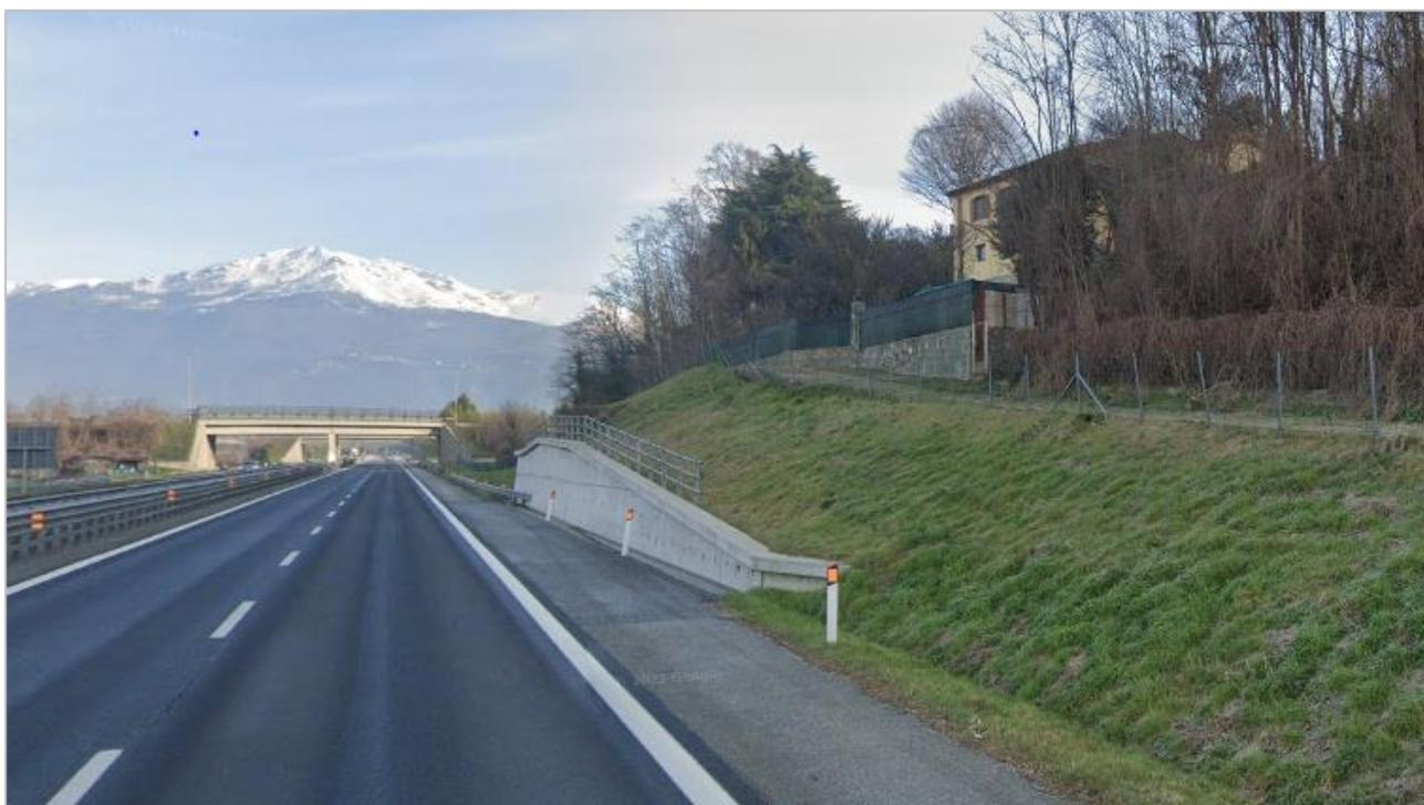
Figura 2.1/4 Vista del tratto di prevista realizzazione della barriera n. 2; la ripresa corrisponde al tratto intermedio, con il muro di sostegno del versante che verrà sostituito da analogo muro con soprastante barriera (fondazione tipo 2 successivo paragrafo 2.3)
