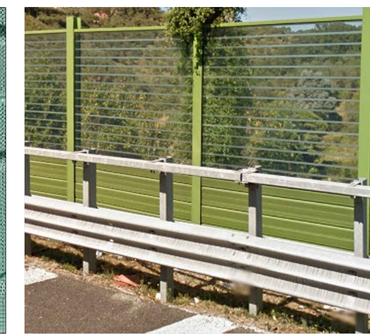
Esempio di pannello in PMMA con serigrafatura antiavifauna
