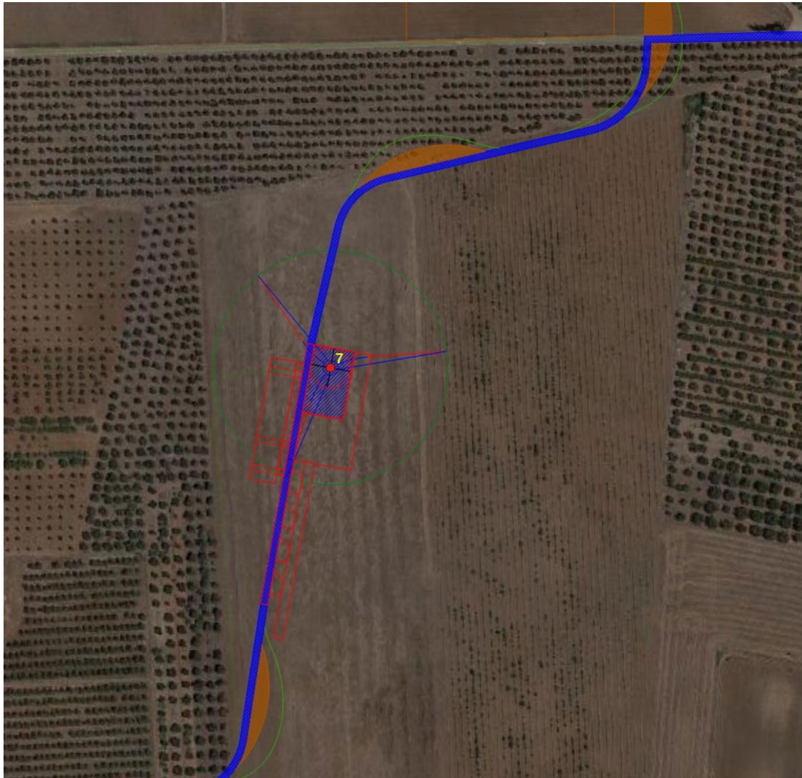
Sito di installazione WTG7 (Foto aerea 2020 - Google)
