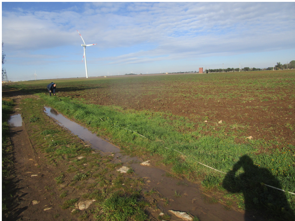
Esecuzione profilo sismico n. 4 – Cabina di connessione
