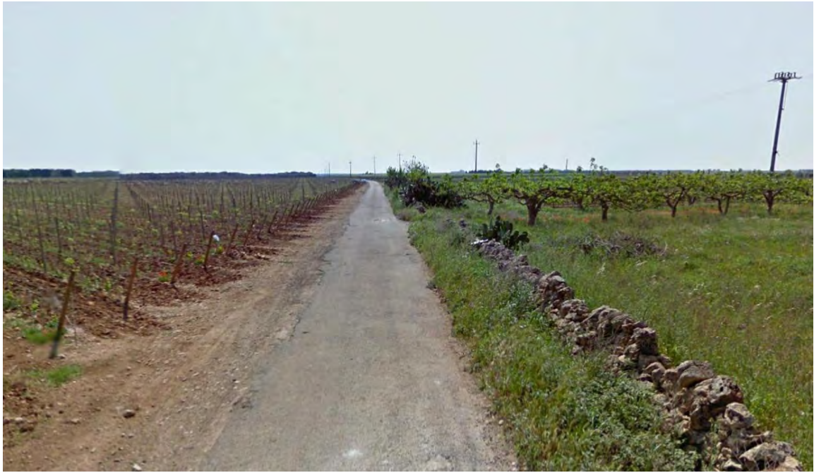
Tratto di strada con cavidotto in TOC. Da precisare che tutti i tratti di interferenza saranno realizzati in TOC
