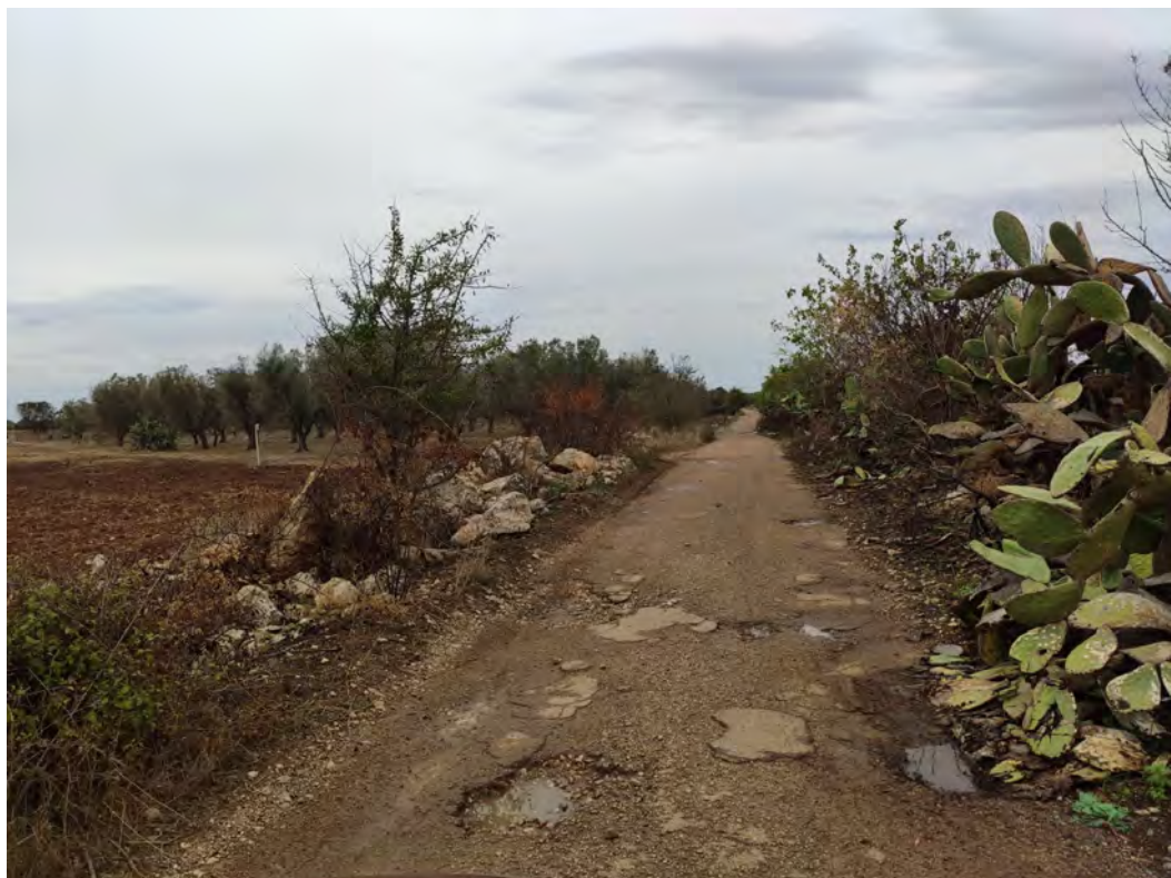
Potatura delle siepe e sistemazione della strada comunale per l'accesso alle WTg S04-S05-S06-S07-S08
