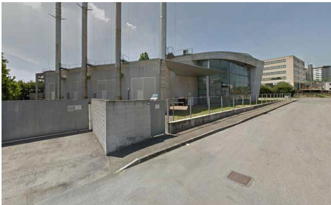
Figura 5.4: Vista No. 3 - Ante Operam
