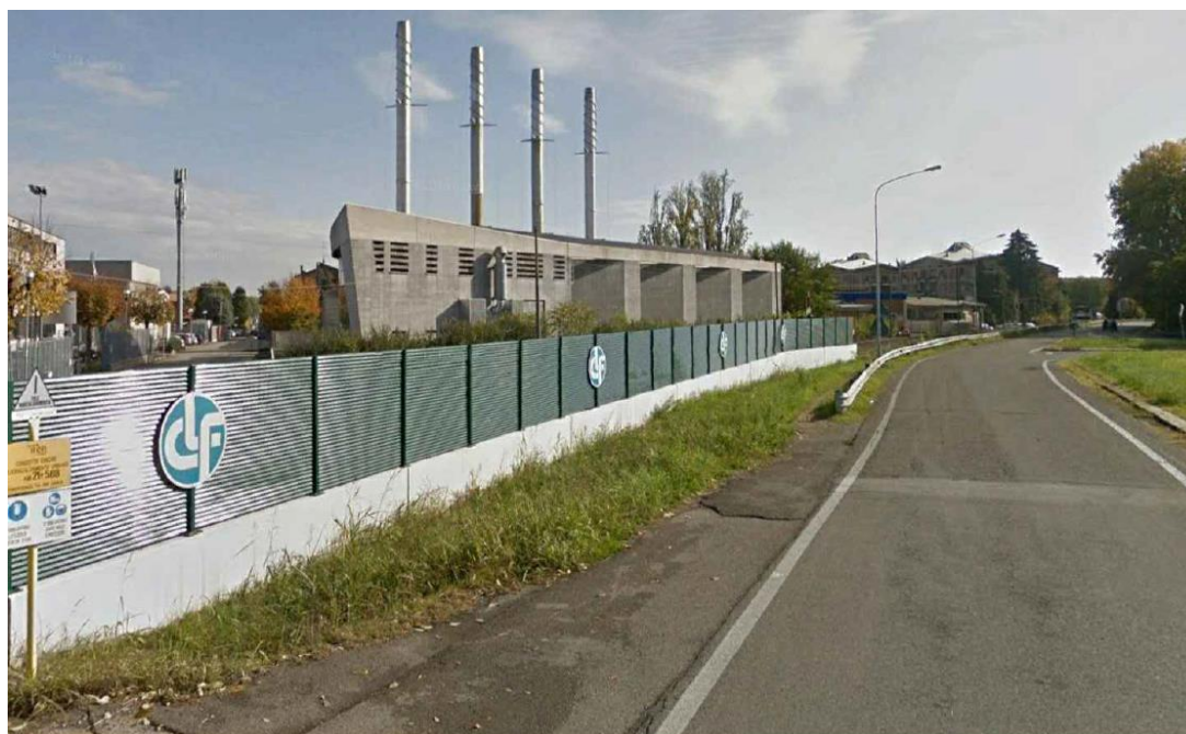
Figura 5.3: Vista No. 2 - Ante Operam
