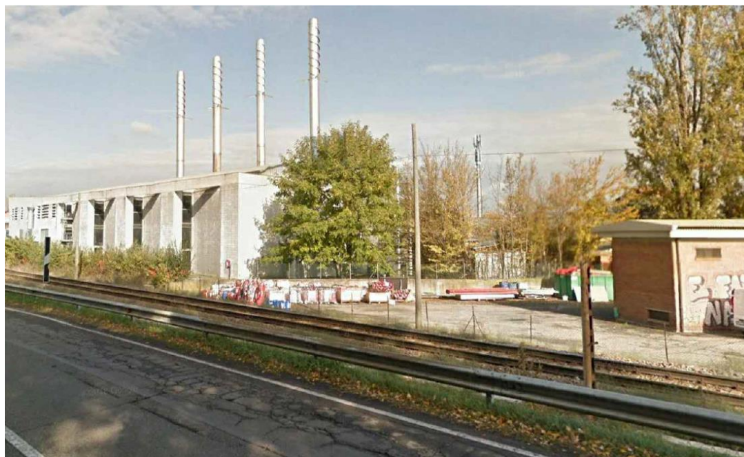
Figura 5.2: Vista No. 1 - Ante Operam
