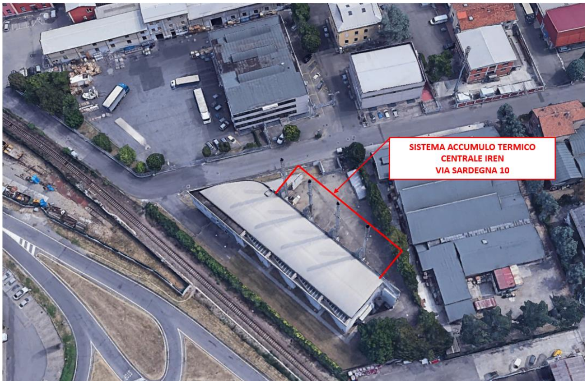
Figura 2.2: Vista della Centrale Termica di Via Sardegna con Localizzazione dell'Area di prevista Realizzazione del Nuovo Sistema di Accumulo Termico
