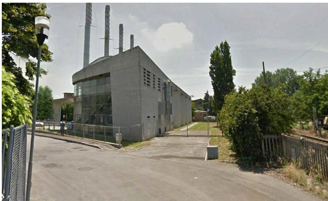
Figura 5.5: Vista No. 4 - Ante Operam
