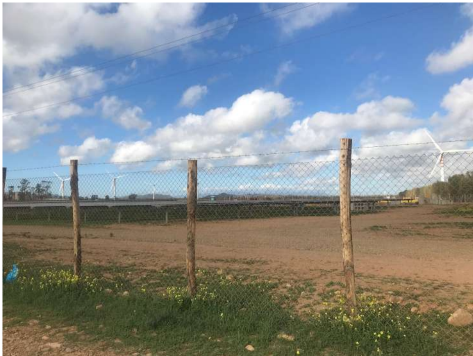
Figure 3-14. Tipologia di recinzione utilizzata
