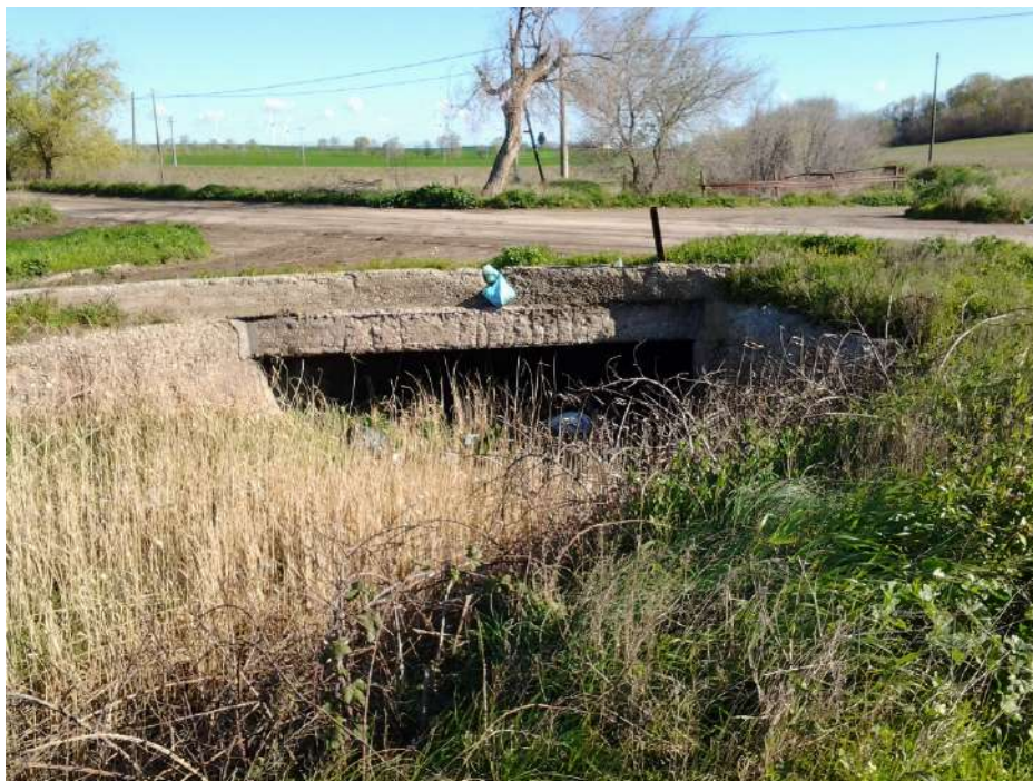
Foto 5. Vista delle condizioni del sovrappasso del canale che sarà attraversato con tecnologia "No-dig".
