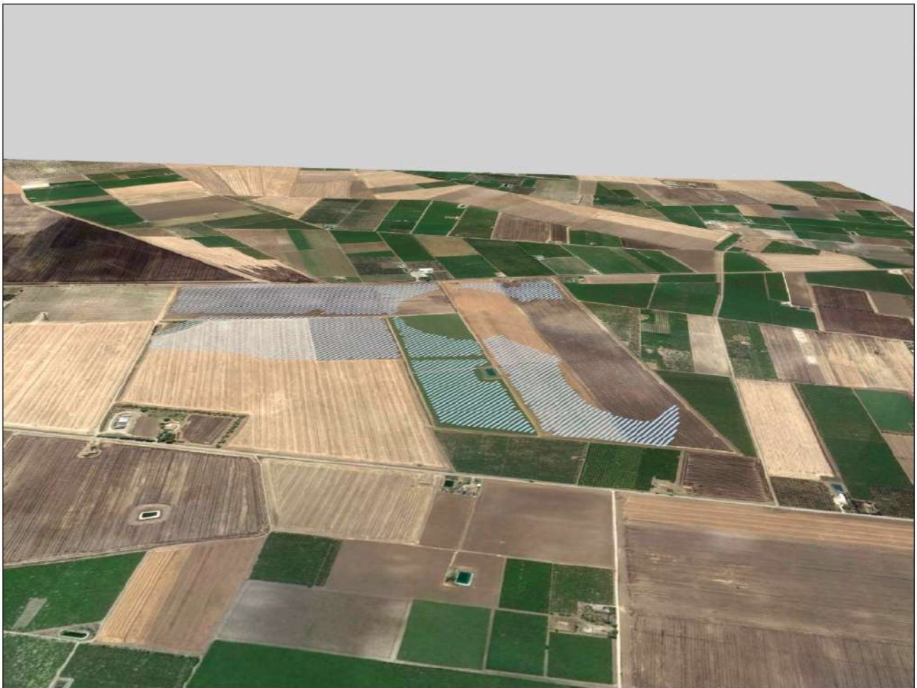
Figure 6-1. Veduta generale dell'intervento
