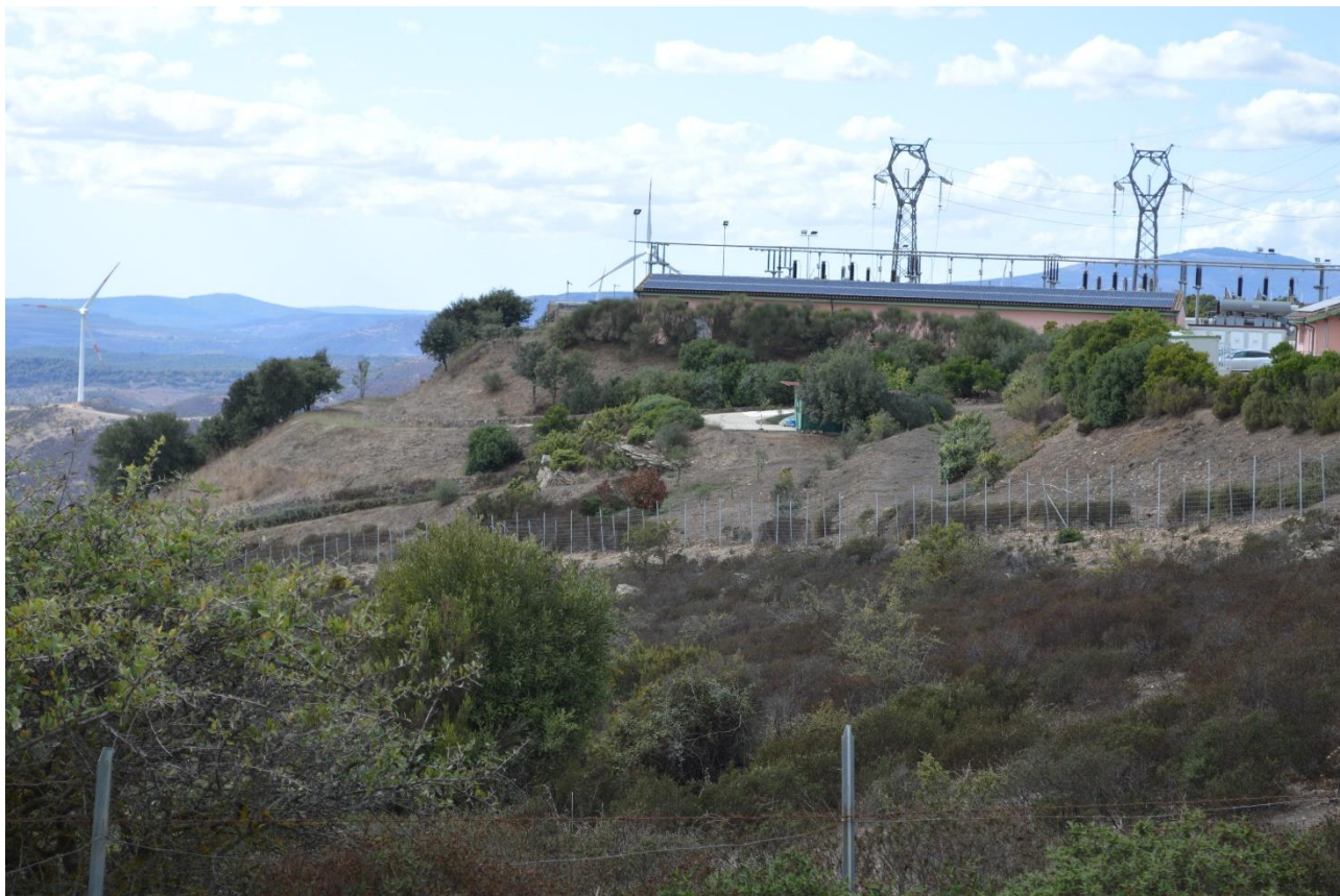
Figura 53 - Stazione di utenza, a contatto con vasti cisteti di sostituzione e coperture vegetali artificiali
