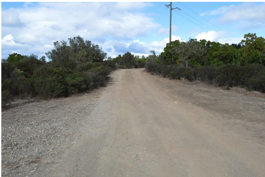
Figura 24 - Tracciato di viabilità da adeguare per il raggiungimento dell'aerogeneratore J05
