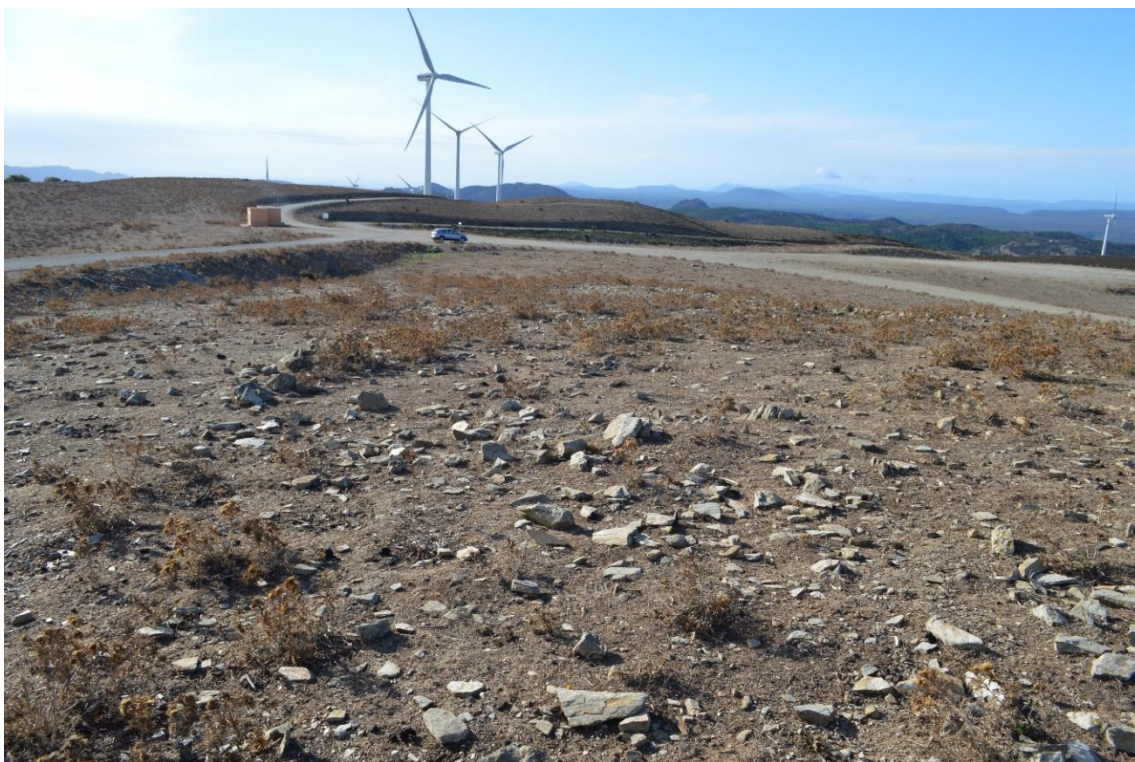
Figura 2 - Futura area di installazione dell'impianto mobile di betonaggio. Vista N → S
