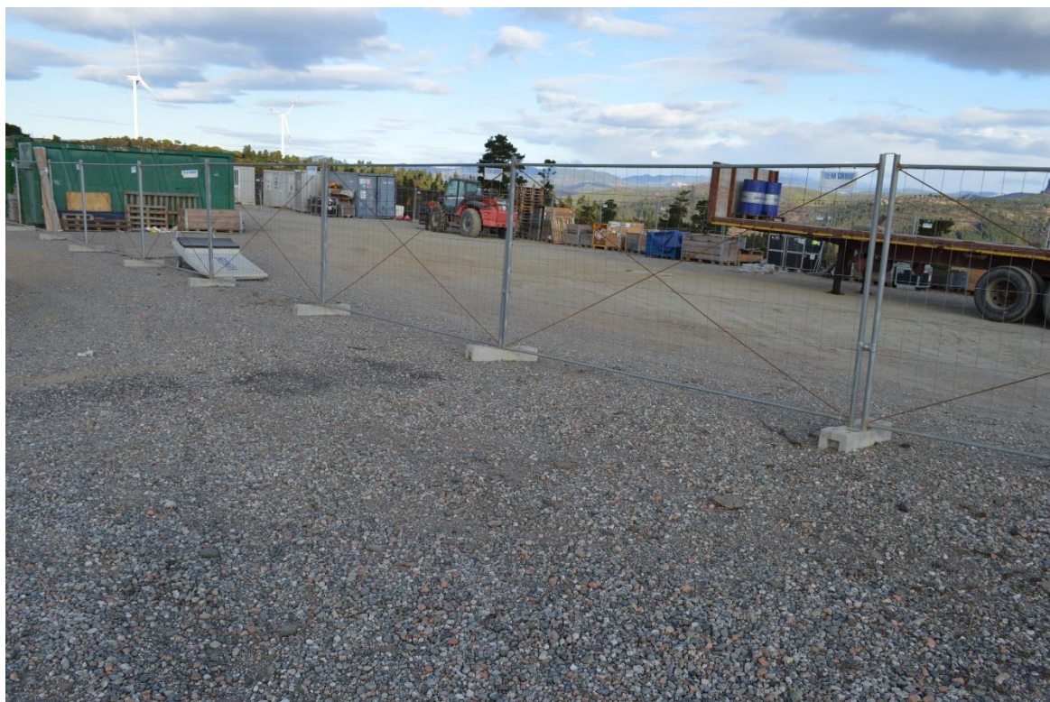
Figura 3 - Area di cantiere localizzata nei pressi della SSE esistente
