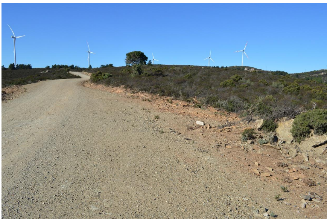
Figura 42 - Superficie interessata dalla realizzazione delle piazzole di supporto dell'aerogeneratore J10
