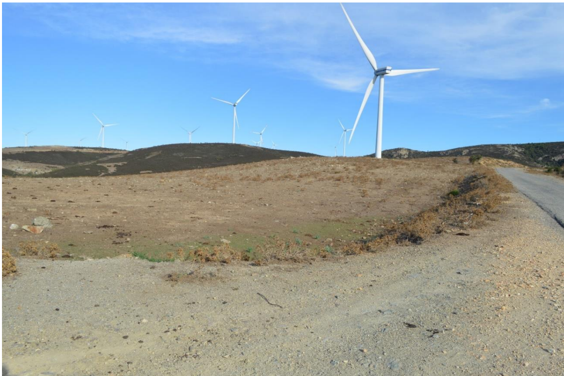
Figura 1 - Futura area di installazione dell'impianto mobile di betonaggio. Vista SE → NW
