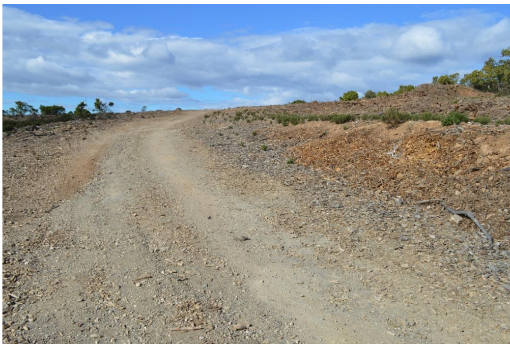
Figura 23 - Superficie interessata dalla realizzazione delle piazzole di supporto dell'aerogeneratore J05
