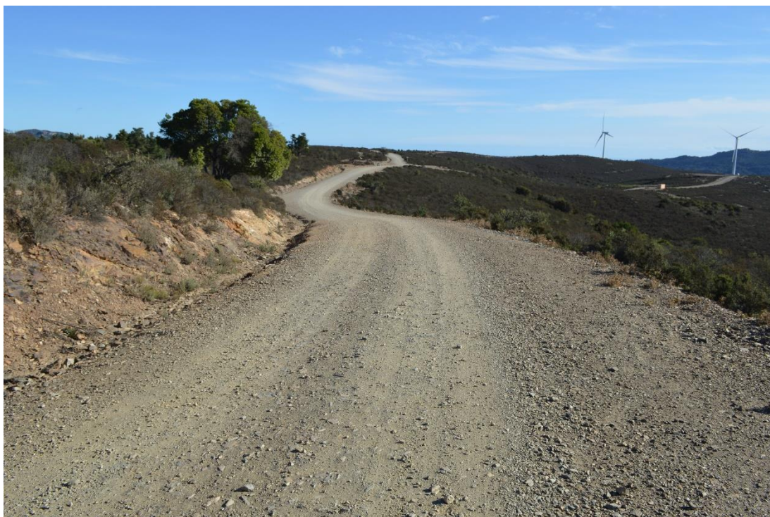
Figura 43 - Tracciato di viabilità da adeguare per il raggiungimento dell'aerogeneratore J10
