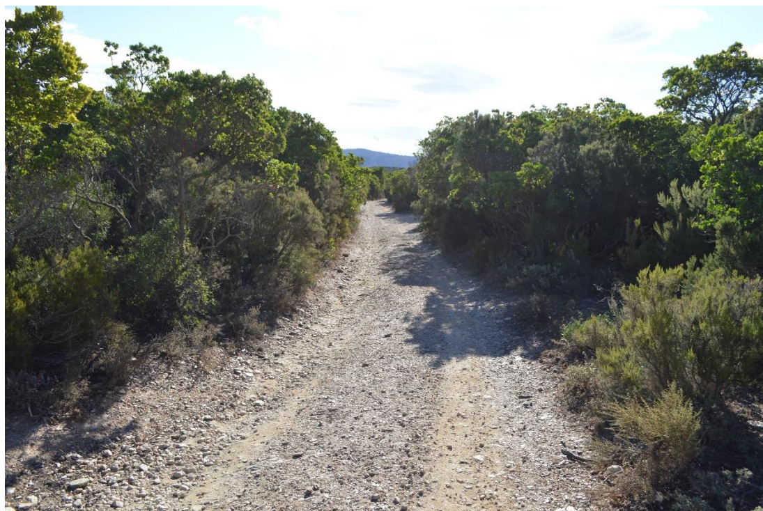
Figura 30 - Tracciato di viabilità da adeguare per il raggiungimento dell'aerogeneratore J07
