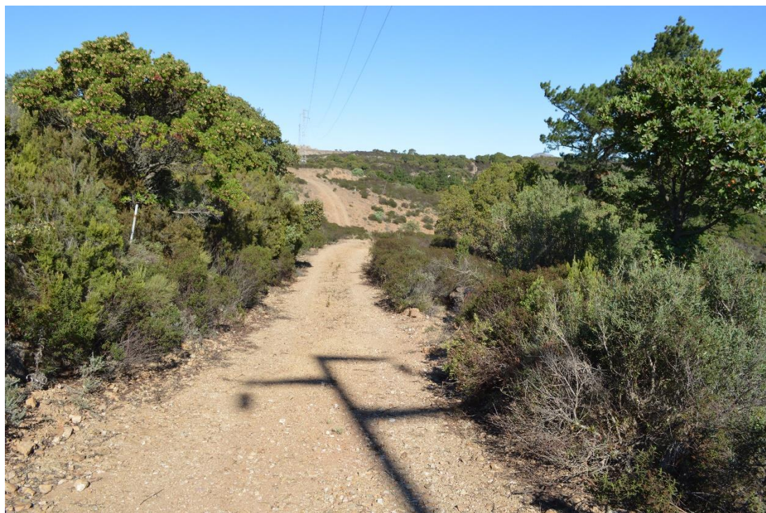
Figura 40 - Tracciato di viabilità da adeguare per il raggiungimento dell'aerogeneratore J009, tratto iniziale con innesto alla strada asfaltata
