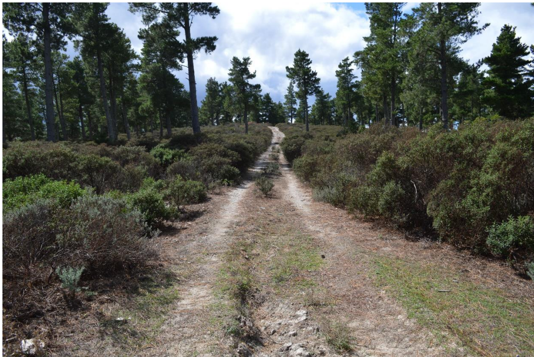
Figura 19 – Tratturo da adeguare per il raggiungimento dell'aerogeneratore J04
