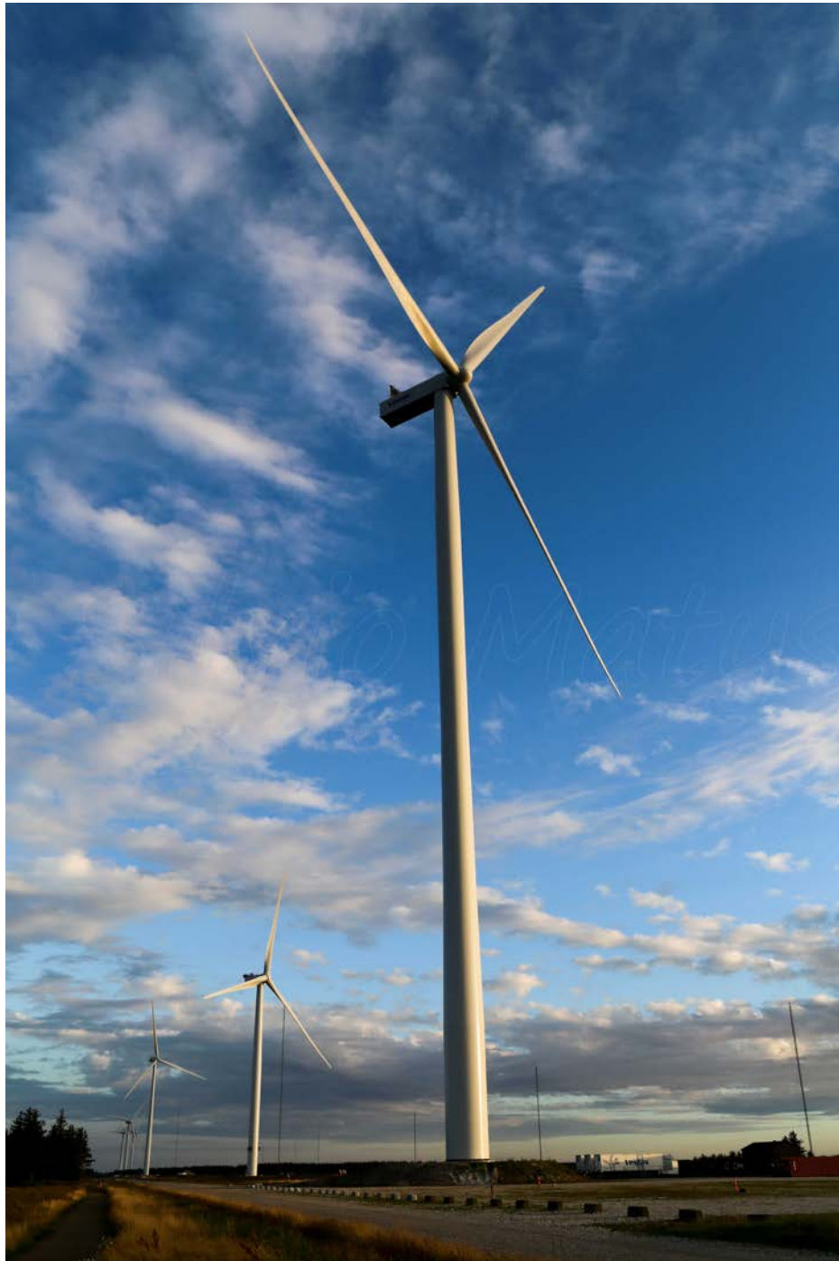
Figura 2. Turbina vestasV150 (Fonte: https://it.wind-turbine-models.com/getfoto-Al6ZtQAoiwl-turbine-vestas_v150-5.6-enventus-Al6ZtQAoiwl.jpg )
