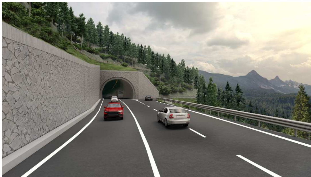
Figura 35: vista di dettaglio della sistemazione dell'imbocco ovest in ingresso della galleria
