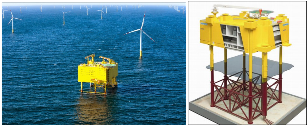
Fig. 10 - Stazione HVAC di trasformazione 66/245 kV
