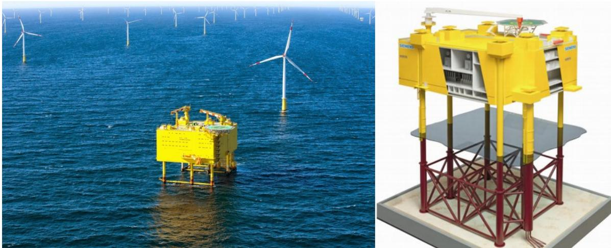
**Figura 9 – Stazione HVAC di trasformazione e conversione HVDC 66/500 kV**
