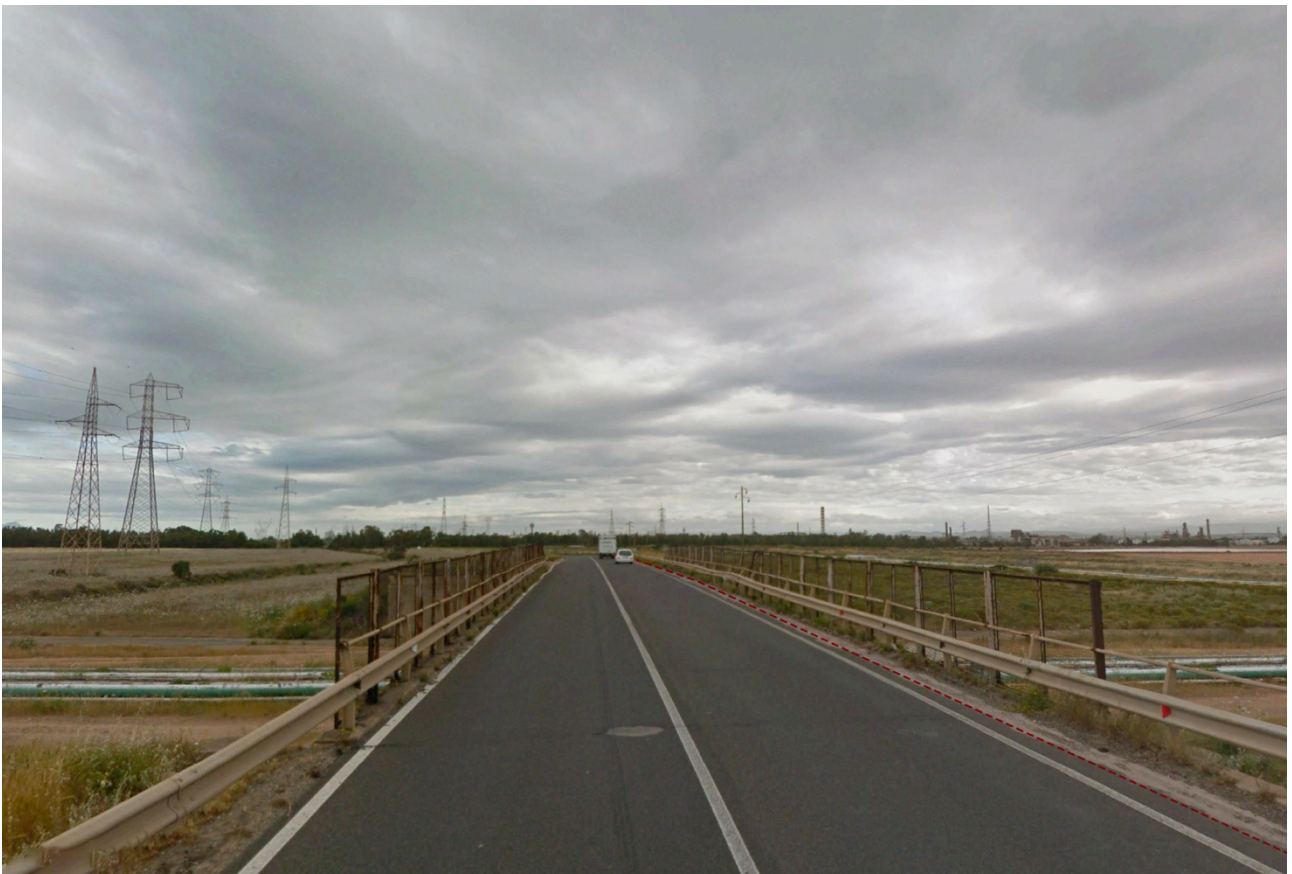
Vista 5_Strada consortile Macchiareddu sovrappasso tubazione oleodotto
