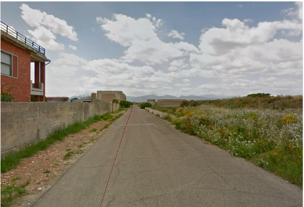
Vista 1_Base molo sud-ovest Porto Canale
