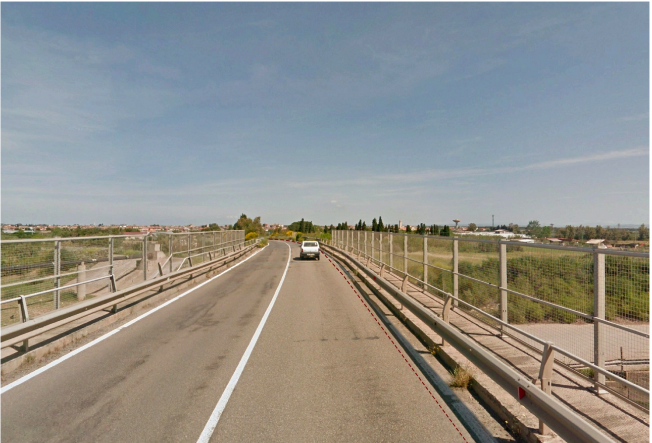
Vista 8_Via Sant'Ambrogio: viadotto
