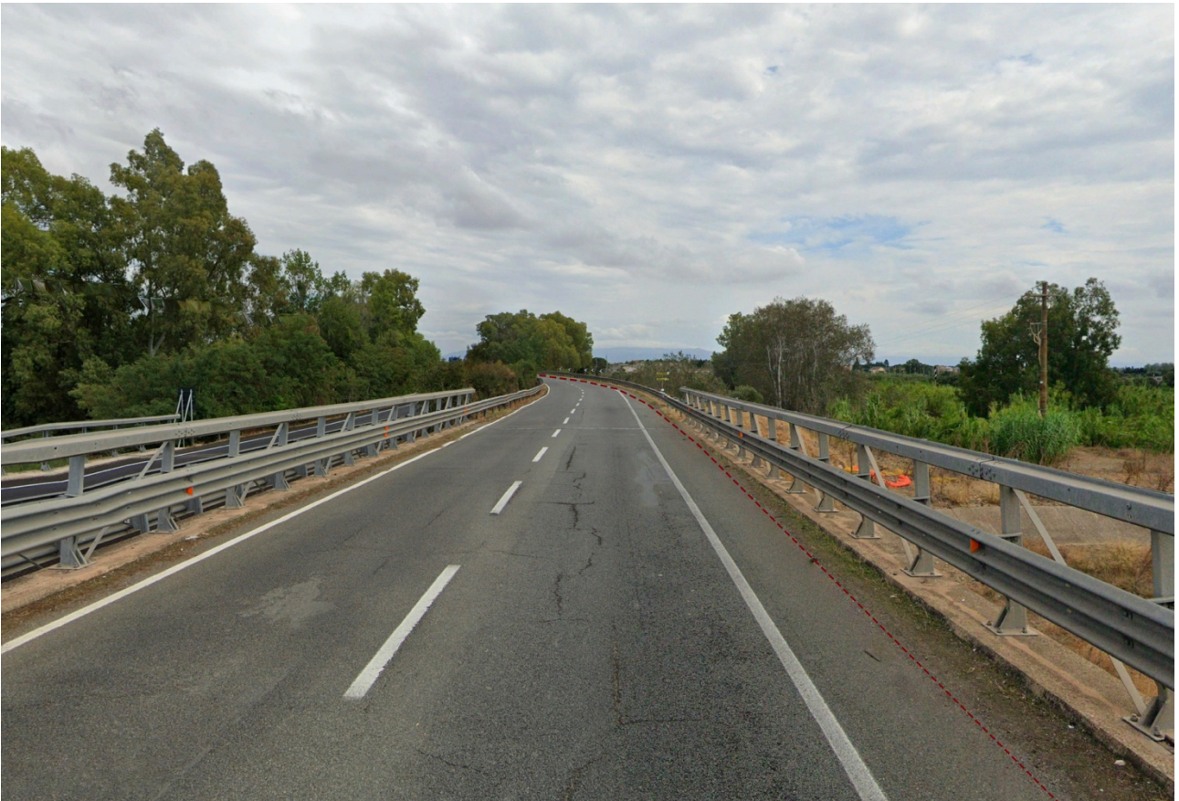
Vista 14_ SS130 viadotto su torrente Leni
