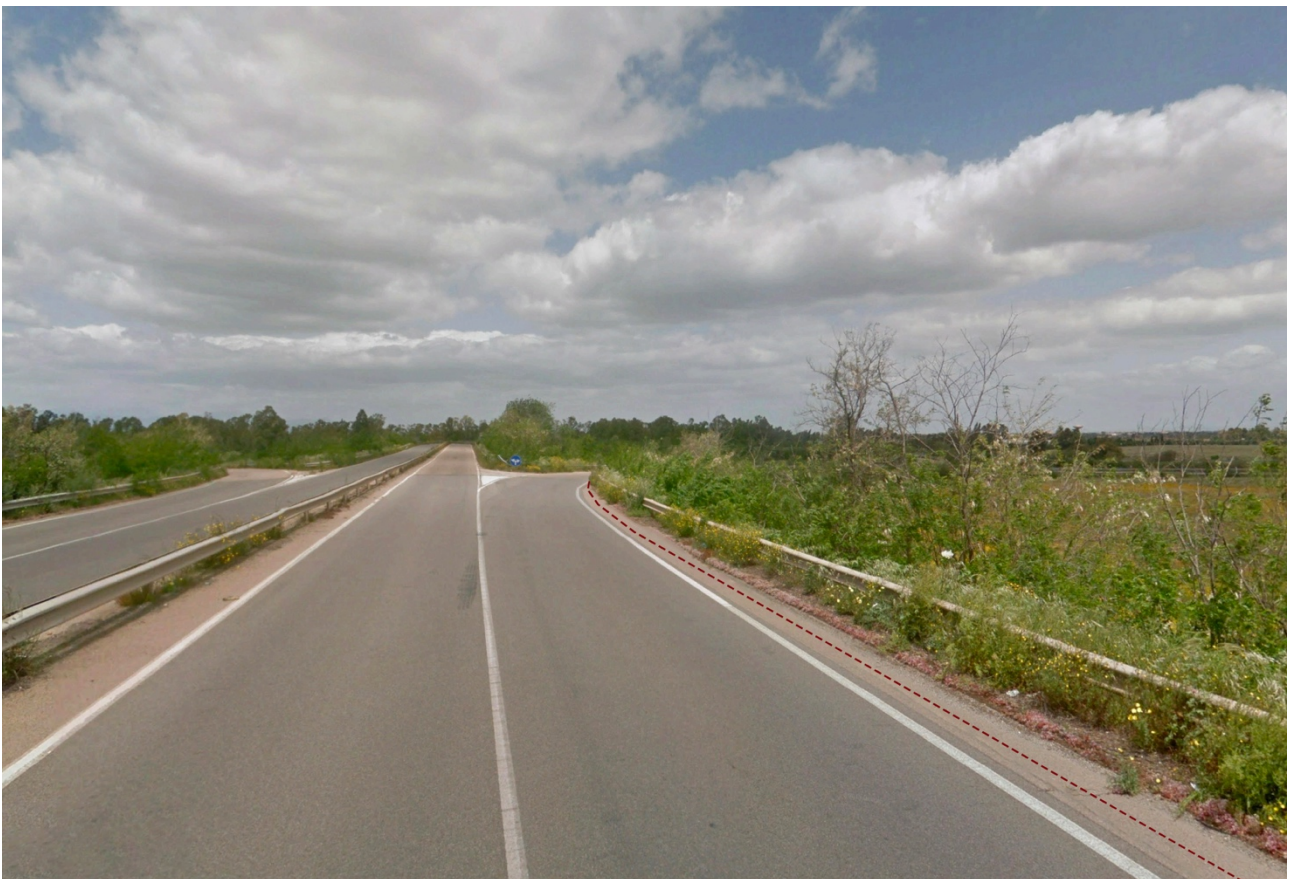
Vista 6_Strada consortile Macchiareddu accesso svincolo su SP2
