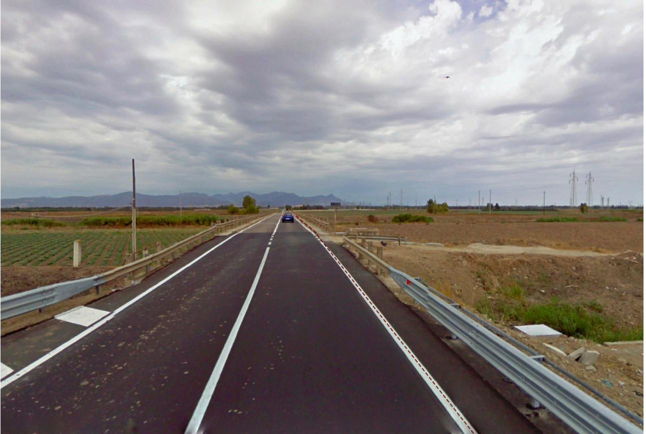
Vista 17_ SS196 viadotto su torrente Leni
