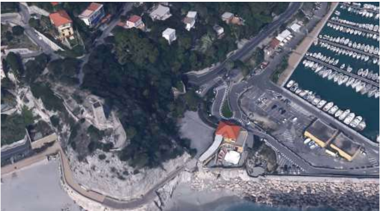
Vista aerea della strada di accesso al porto, situata all'imbocco della galleria posta sotto Capo San Donato
