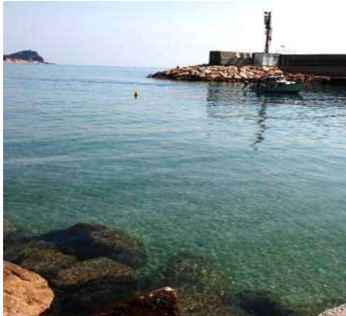
L'imboccatura del porto ripresa dalla testata del molo di sottoflutto: si nota il basso pescaggio, sintomo di insabbiamento, e l'eccessiva apertura verso levante.
