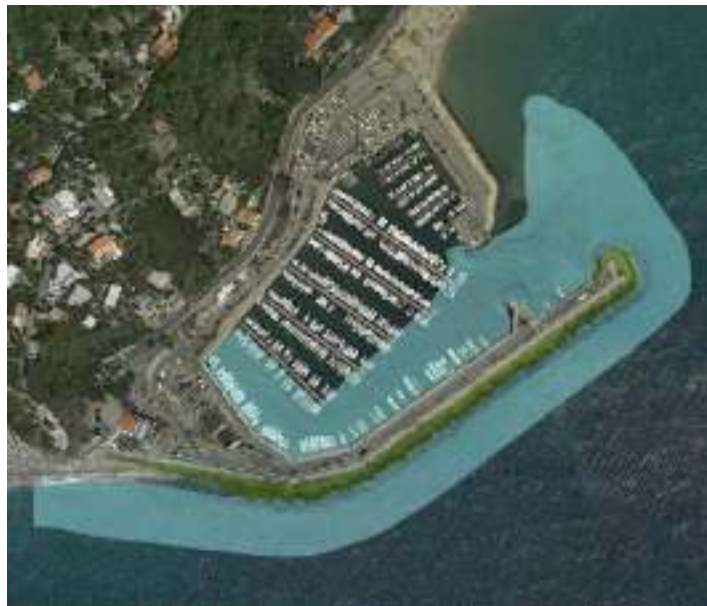
Area d'indagine e zona del rilievo
