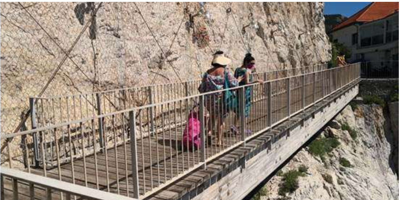
La nuova passeggiata pensile di capo San Donato che conduce al Porto, prima raggiungibile solo con la galleria veicolare
