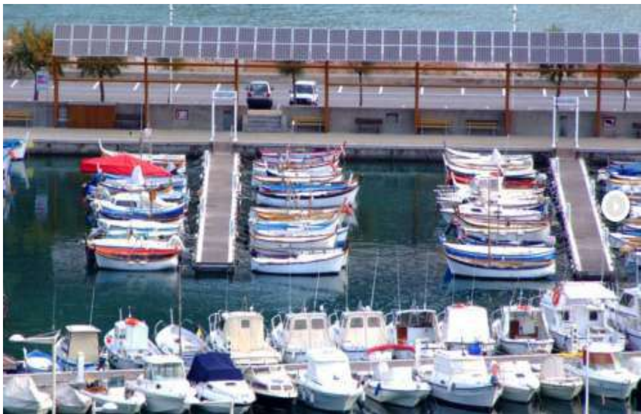
La tettoia ombreggiante con pannelli fotovoltaici.
