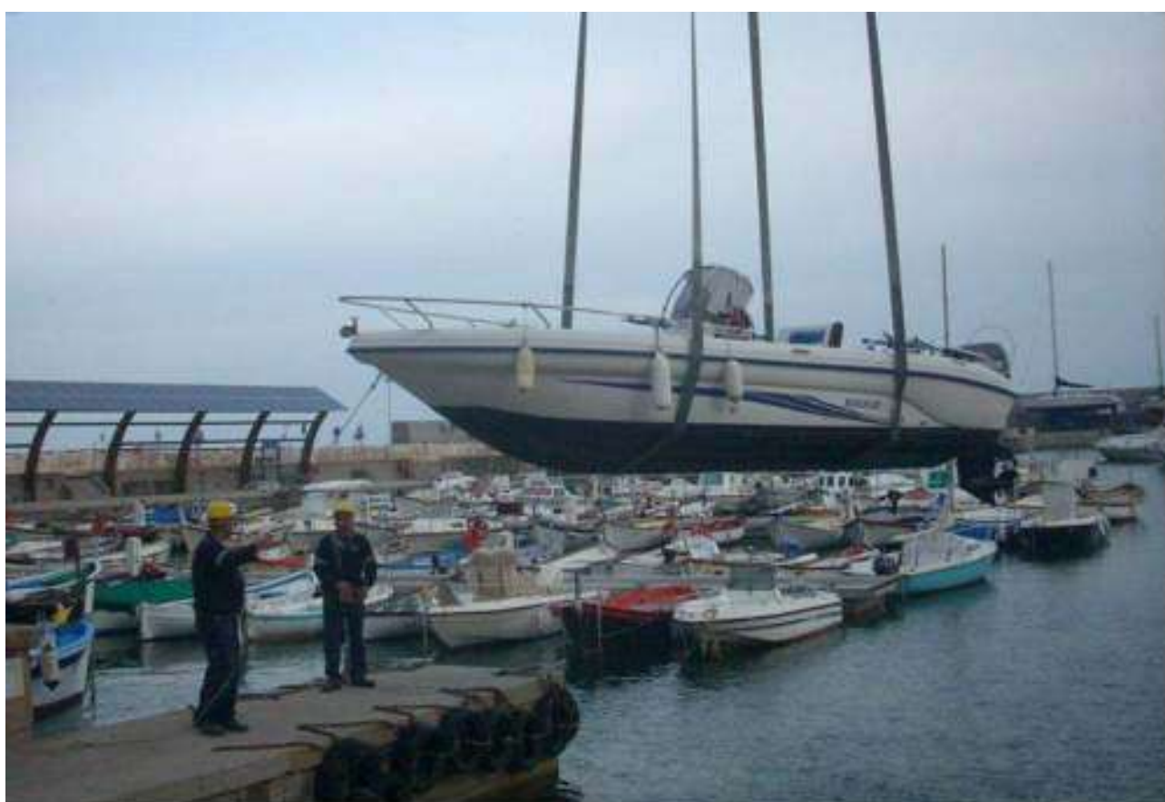
Gru fissa da 3,5 tonnellate per la movimentazione delle imbarcazioni
