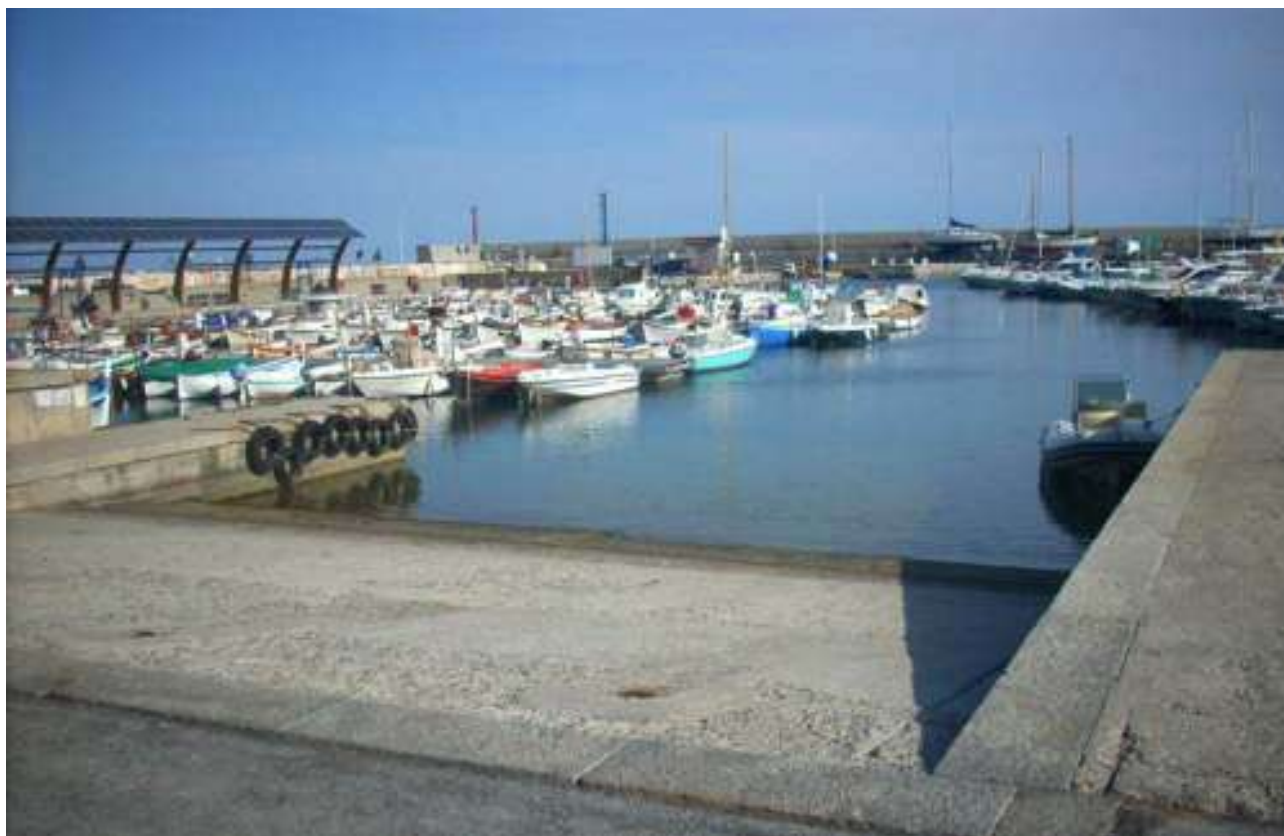
Scivolo per le operazioni di varo e alaggio di piccole imbarcazioni
