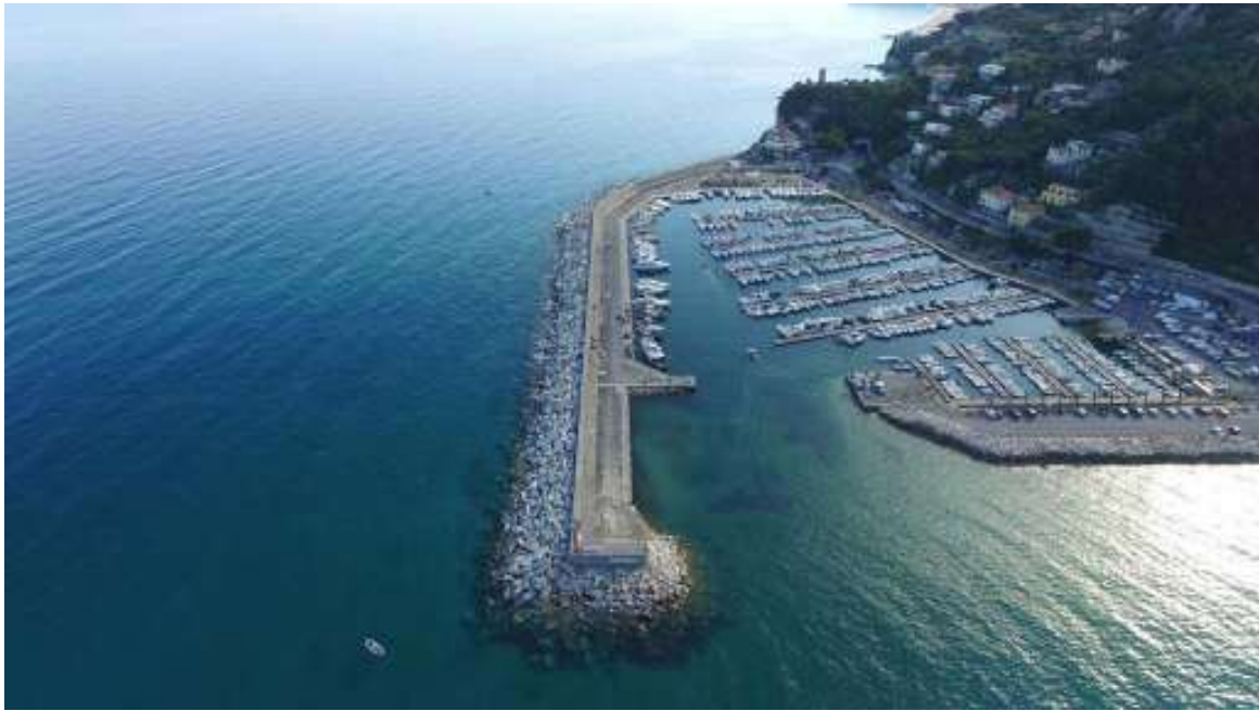
Foto aerea del Porto di capo San Donato che evidenzia l'eccessiva ampiezza dell'imboccatura portuale, rivolta verso Levante. Si nota anche la differenza cromatica dei fondali e il relativo l'insabbiamento
