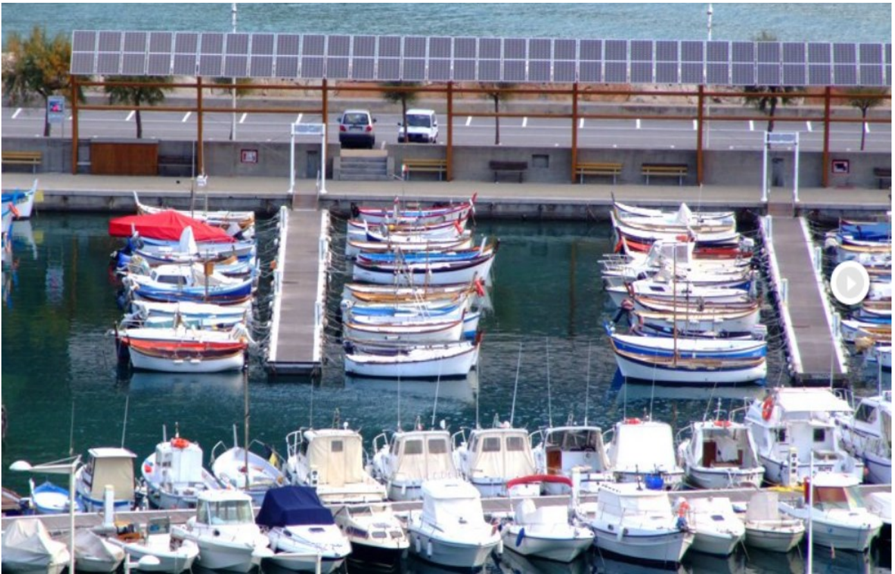
La tettoia ombreggiante con pannelli fotovoltaici.
