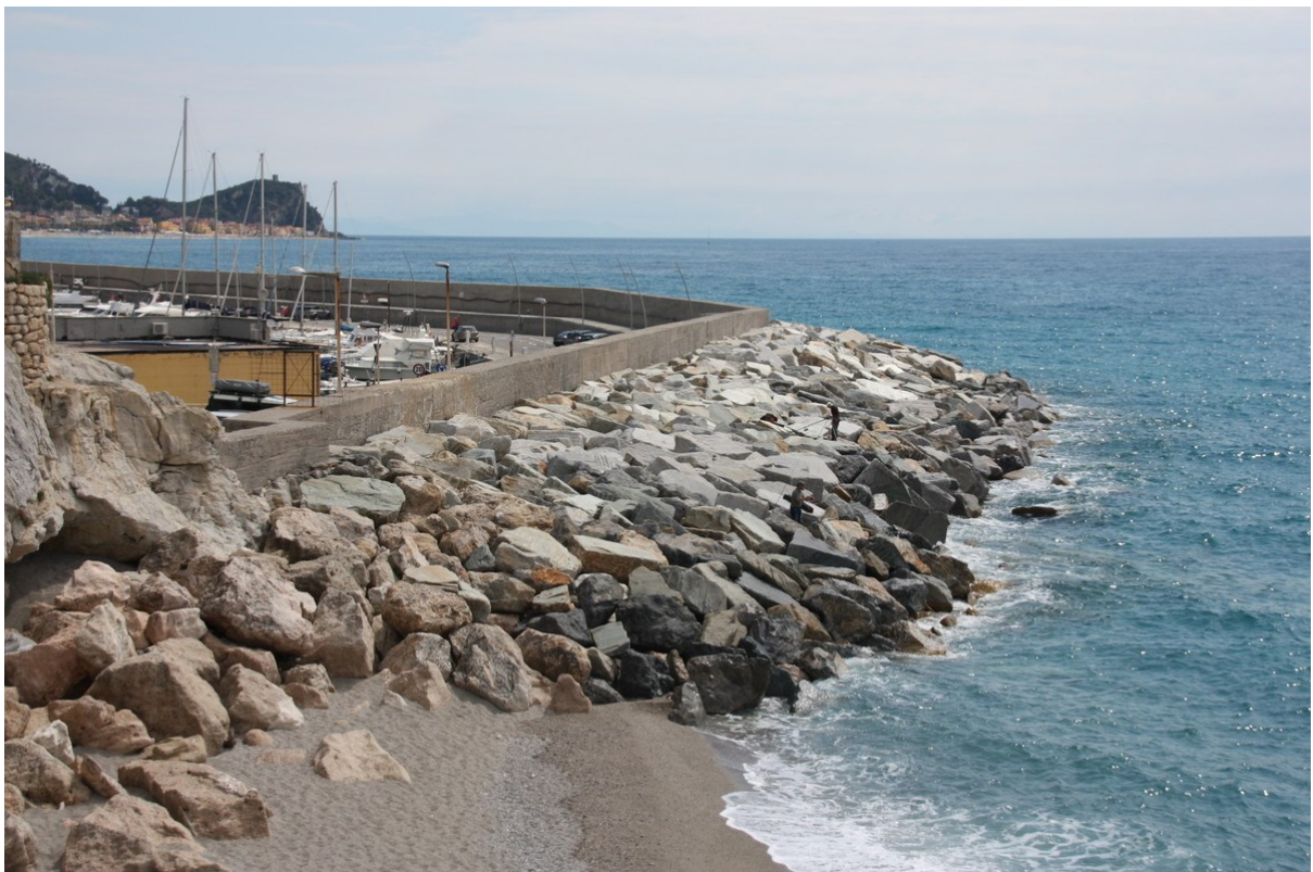
Il braccio verso terra della diga di sopraflutto
