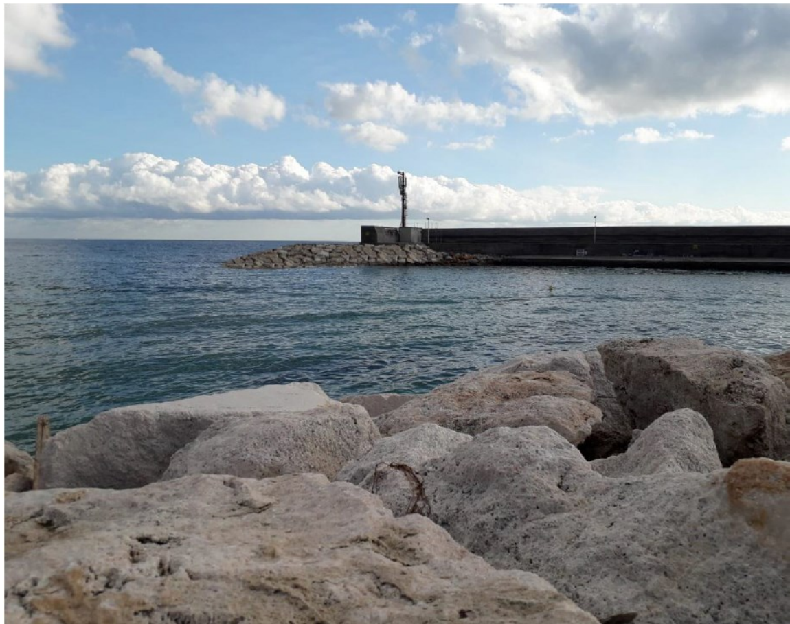
Fotoinserimento progettuale relativo al ringrosso della testata del molo foraneo (molo di sopraflutto), in via di esecuzione. Confronto tra situazione attuale (in alto) e di progetto (in basso).
