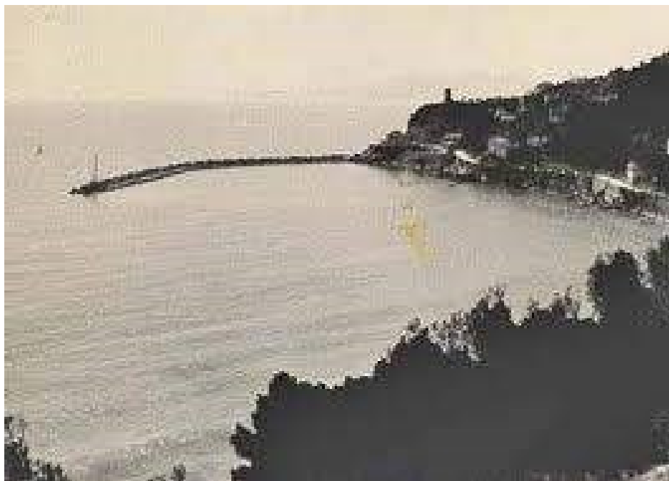
La costruzione della diga di sopraflutto negli anni Sessanta
