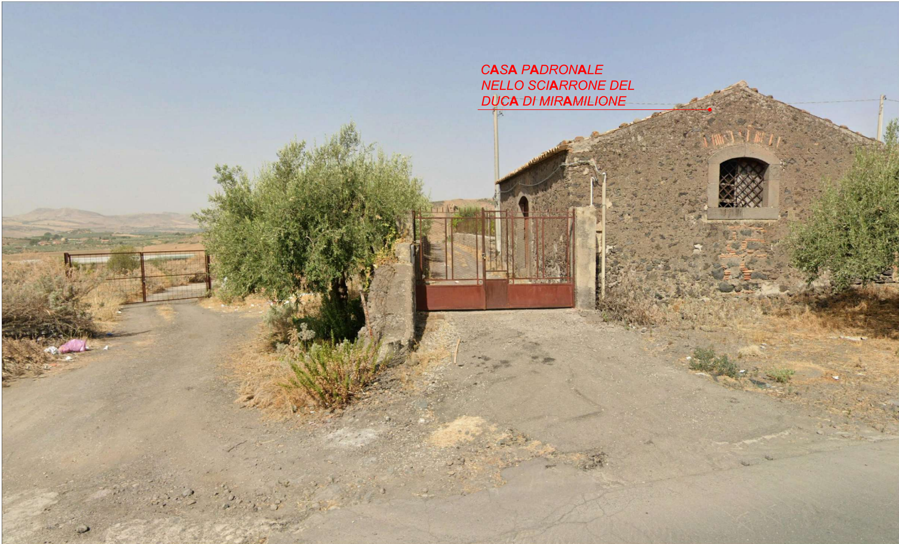
Foto D - area di impianto visibile
