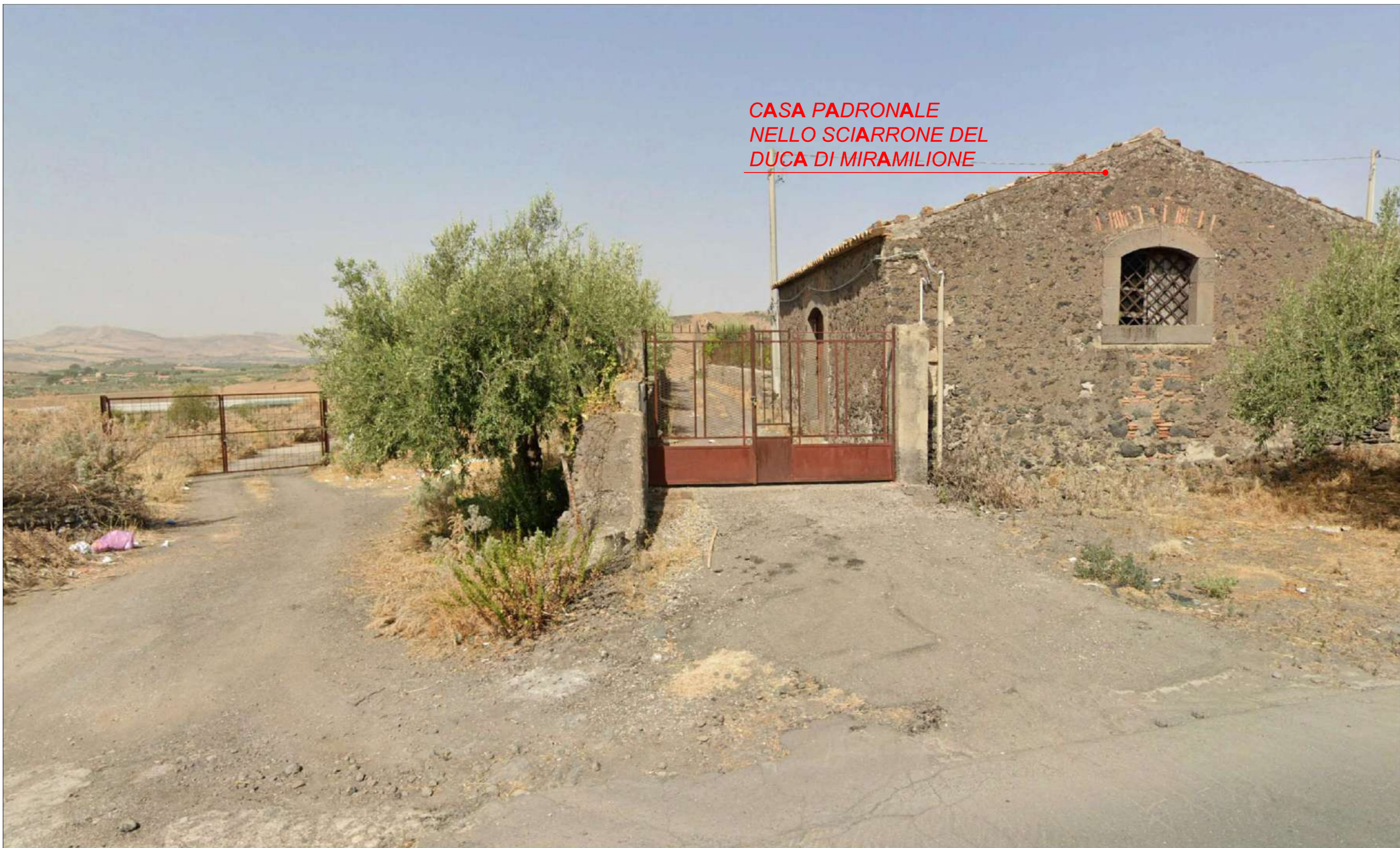
Foto D - area di impianto visibile
