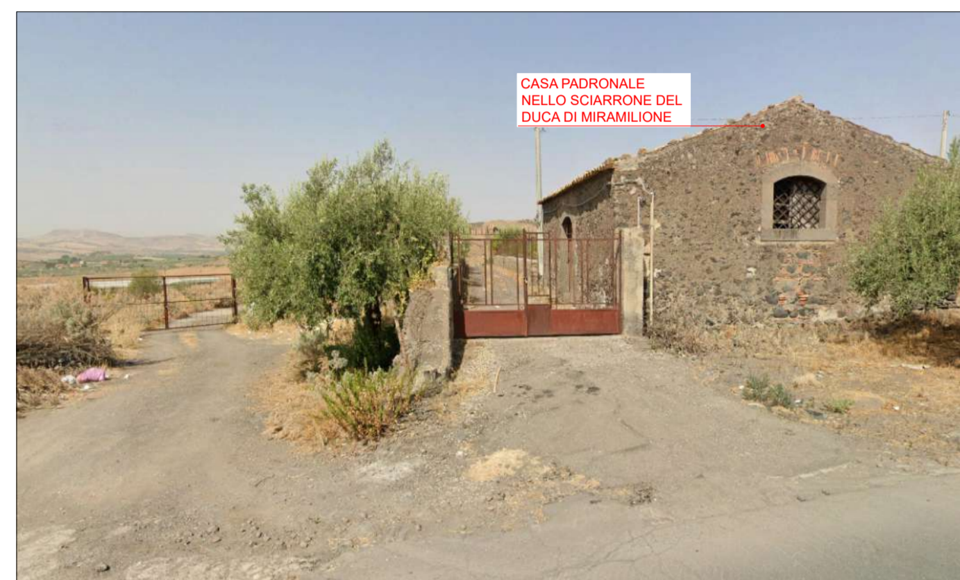
Foto D - area di impianto visibile
