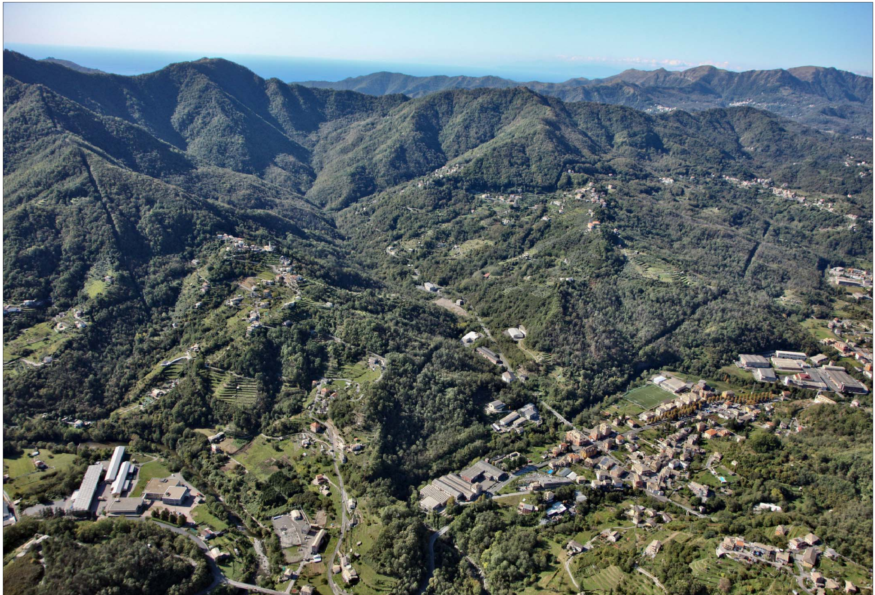
Ponte sul Torrente Lavagna Stato di fatto
