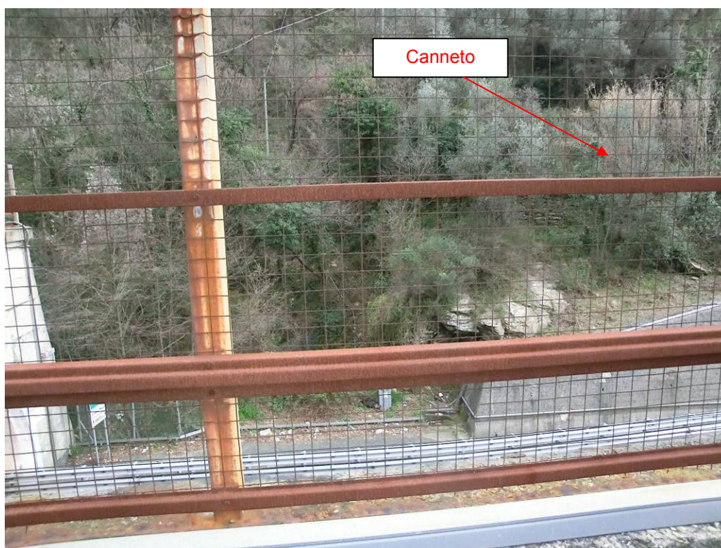
Figura 45 - Area imbocco S Galleria Caravaggio
