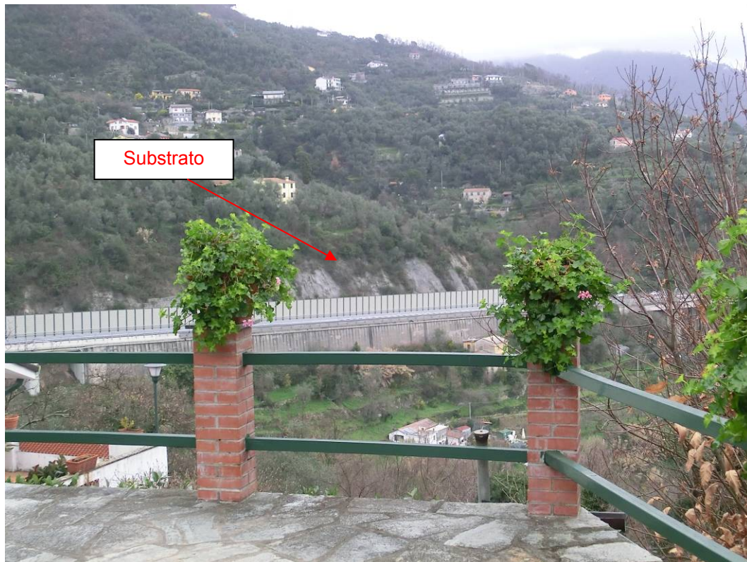
Figura 40 - Roccia affiorante al di sopra del muro di controripa dell'Autostrada.
