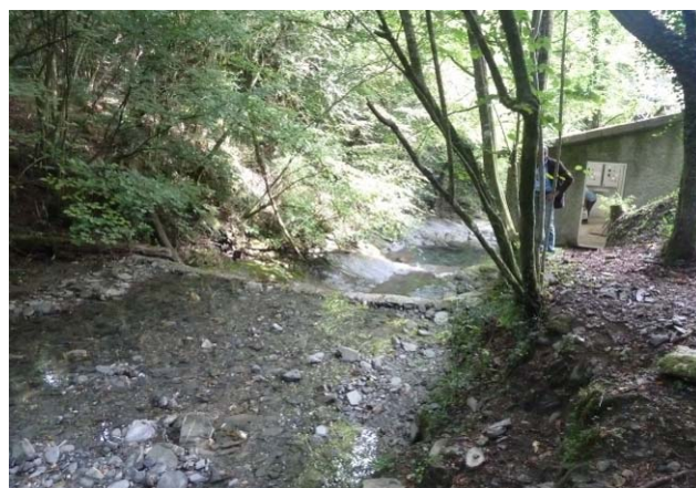
Foto 15 - Presa in sub alveo dell'acquedotto di Cicagna (S 519).
