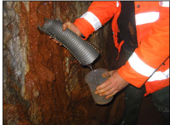
Foto 17 - Operazioni di misura della portata dalle venute idriche attraverso fratture oppure drenaggi.
