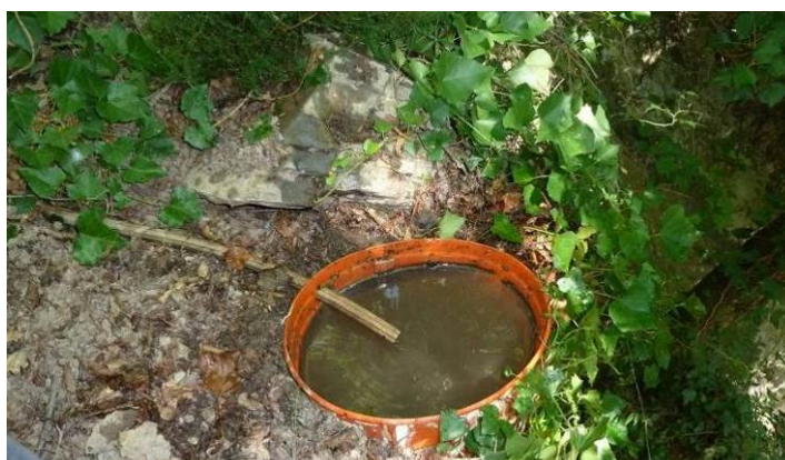
Foto 3 - Esempificazioni della precarietà delle presa in alveo.
