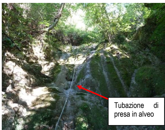
Foto 3 - Esempificazioni della precarietà delle presa in alveo.
