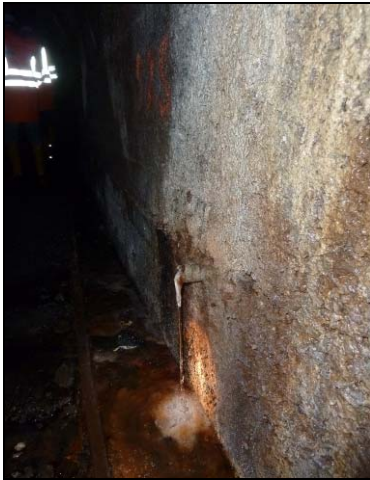
Foto 1 - Punto di campionamento alla progressiva km 0+975 della galleria dell'acquedotto in corrispondenza di venuta con odore di anidride solforosa.
