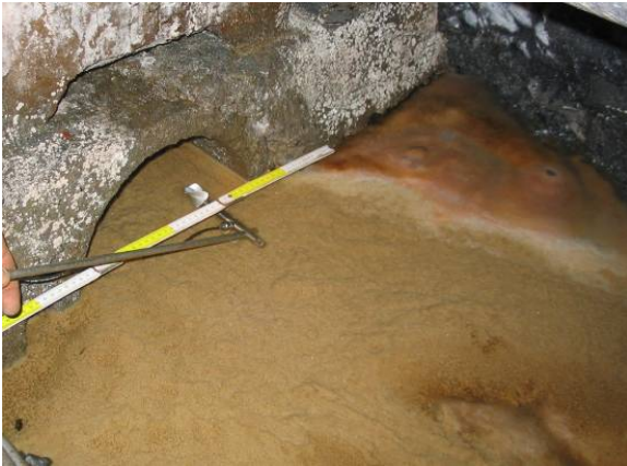
Foto 16 - Punto di misura della portata correntometrica alla progressiva km 1+950.
